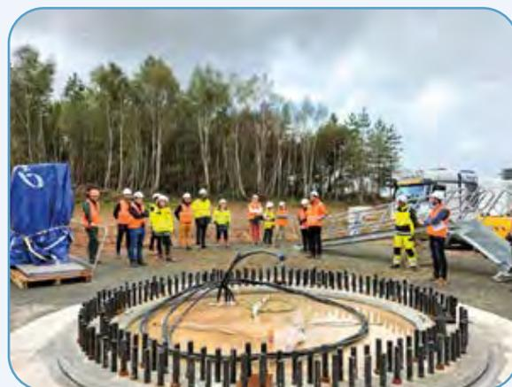
Visite du 8 septembre : explications autour de la surface de la fondation de l'éolienne E3, d'où ressortent les tiges d'ancrage pour fixer la première section du mât.
