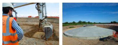
Cela passe par des travaux de terrassement et de renforcement de sol si nécessaire. Le ferrailage de fondation et la section d'ancrage sont ensuite mis en place avant le bétonnage de la fondation. Enfin, la terre est remblayée jusqu'à la base du mât de l'éolienne.
