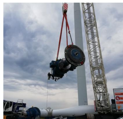
Parc éolien de Xambes-Vervant (16) - Exemple d'un remplacement du palier principal de l'éolienne 3 (mai 2018)
