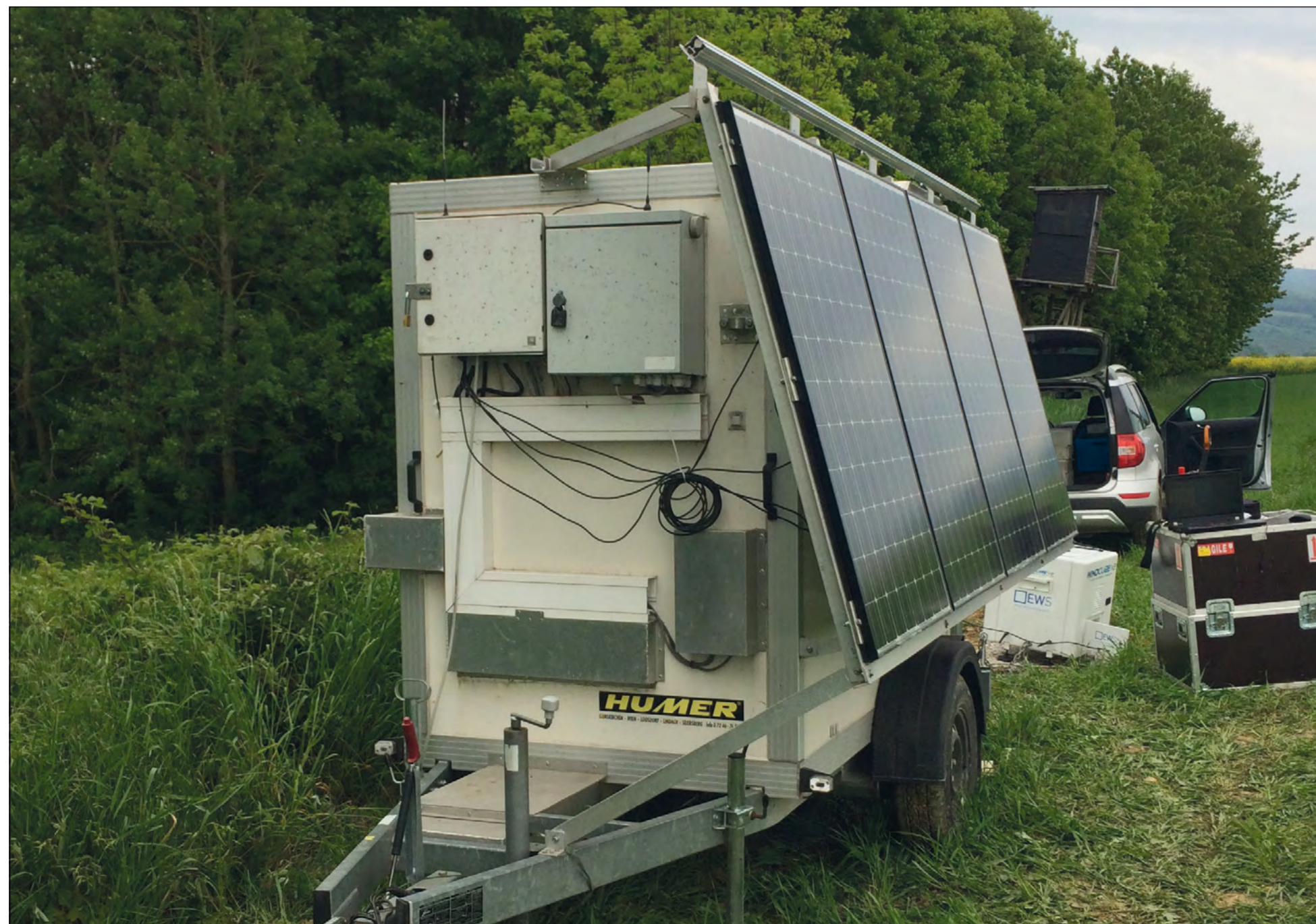
Transporter mit Solarmodulen
