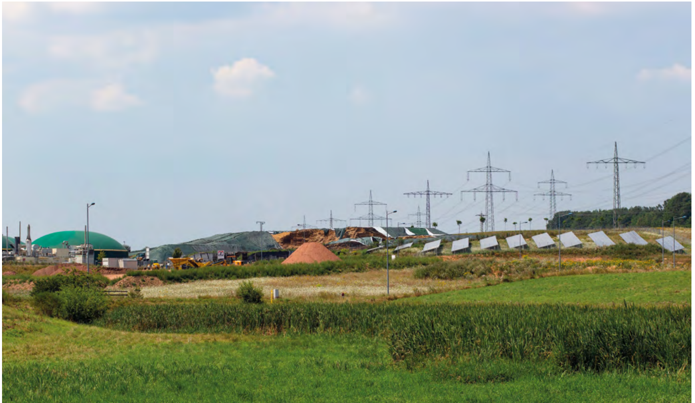
En 2018, ABO Wind completó la modernización de la planta de biogás de Ramstein e instaló en el recinto módulos solares que cubren parte de la demanda de electricidad.
