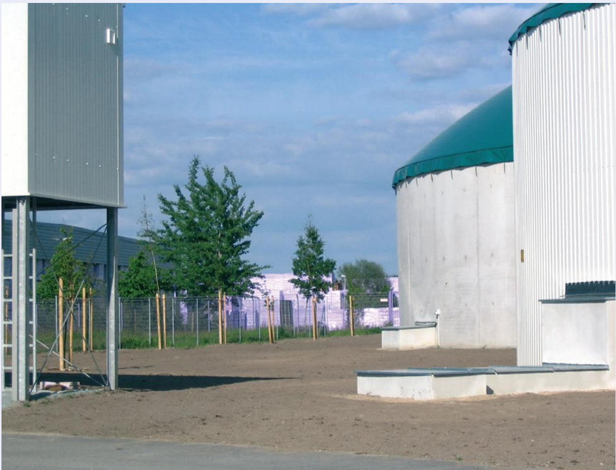
Planta de biomasa en Mechau
