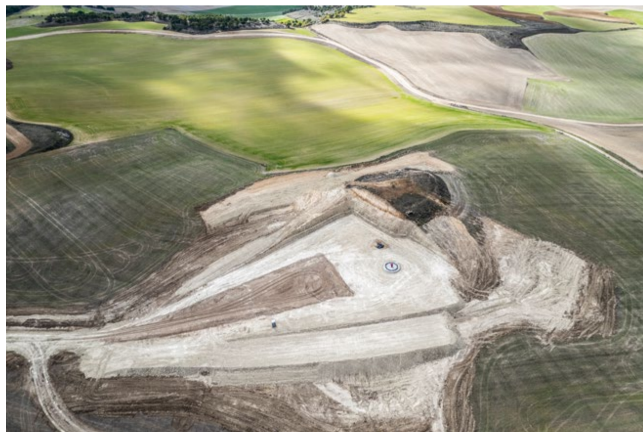
Movimiento de suelo en plataformas
