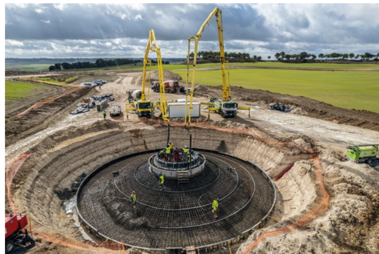
Construcción de la cimentación de la base de un aerogenerador
