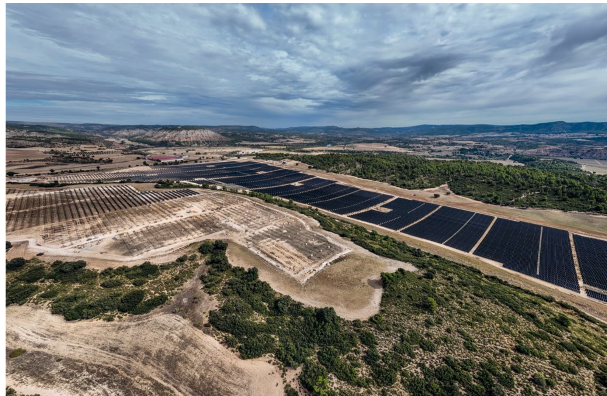
Parque Fotovoltaico Valdezorita
