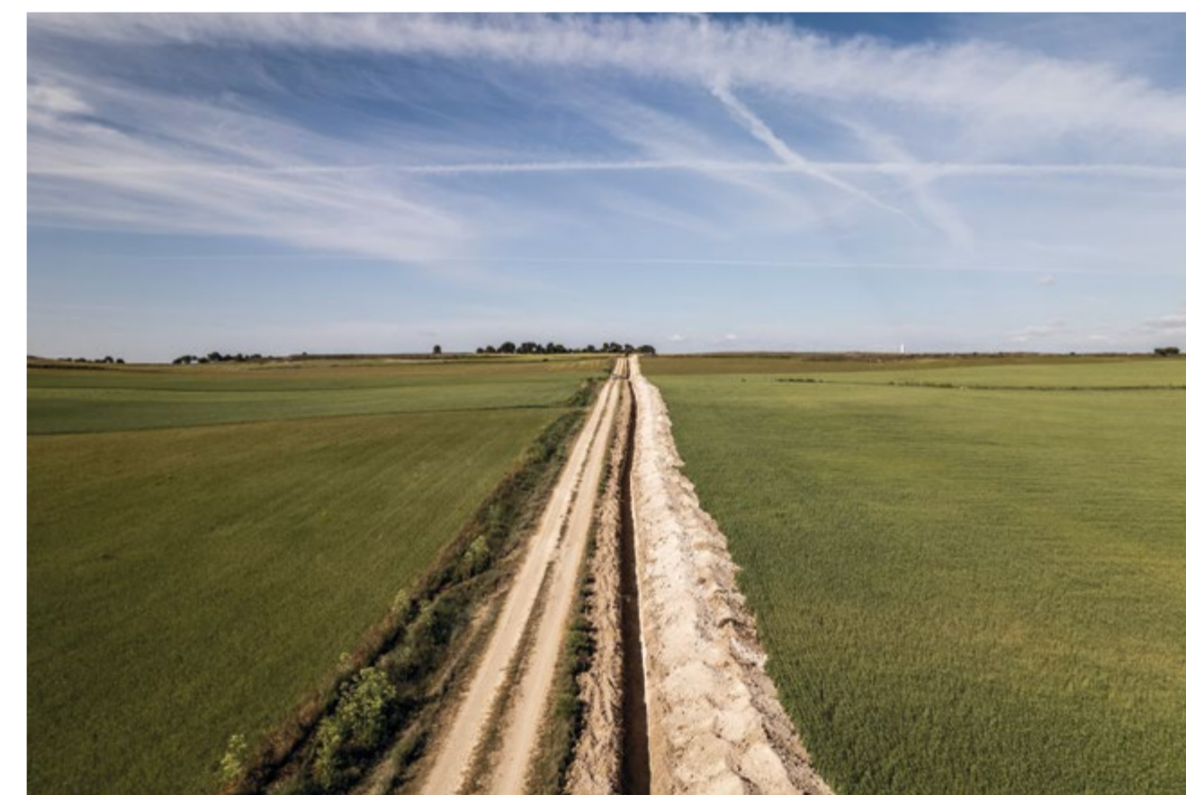
Zanja para línea eléctrica subterránea
