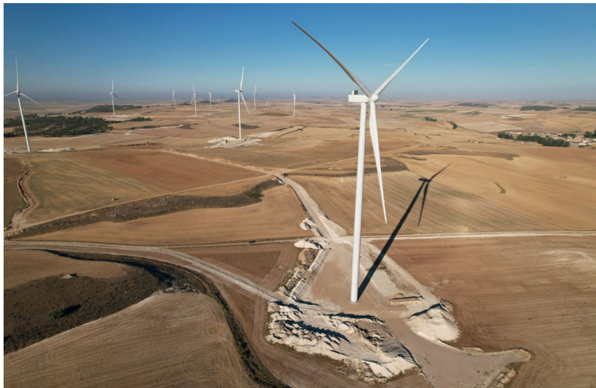
Parque Eólico Andella
