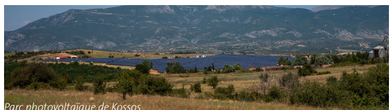
Parc photovoltaïque de Kossos
