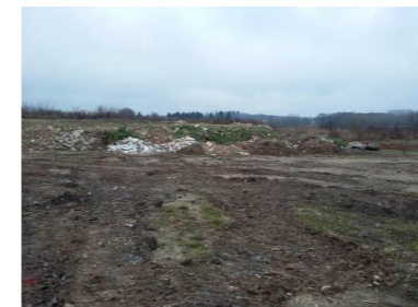
Photo d'ensemble du site en 2017 (source : TAUW)
