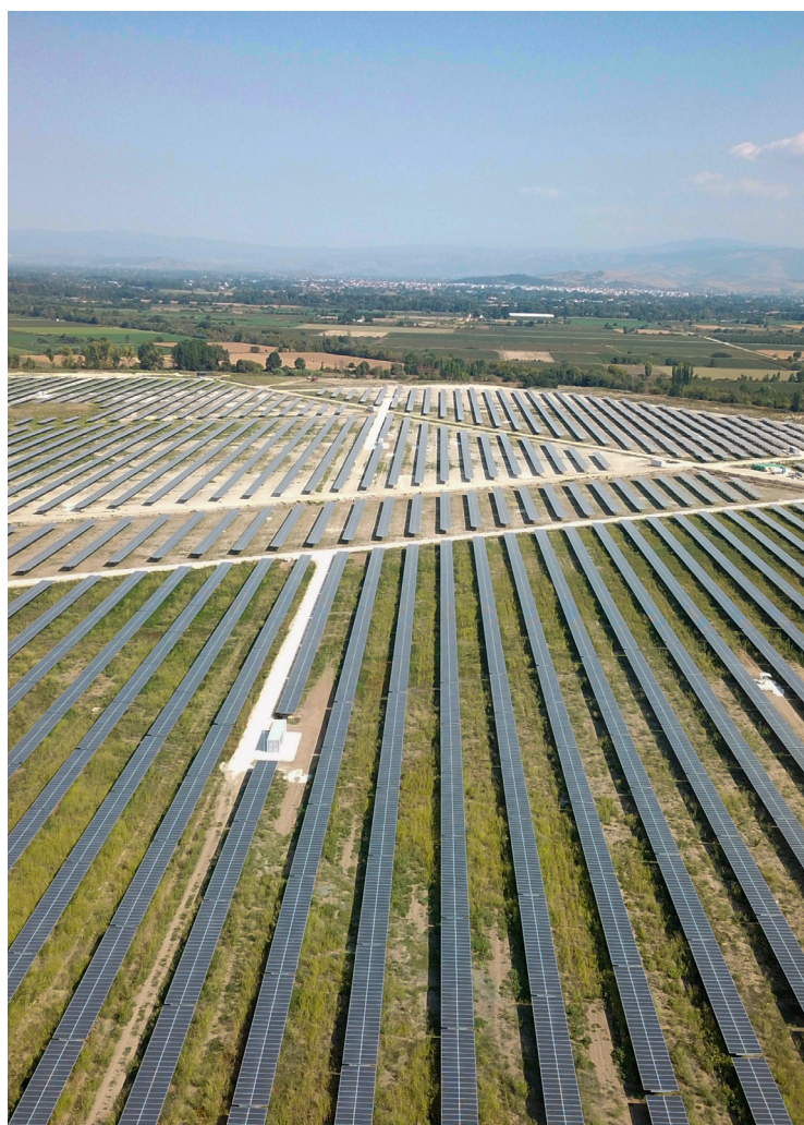
©ABO Wind - parc photovoltaïque de Megala
