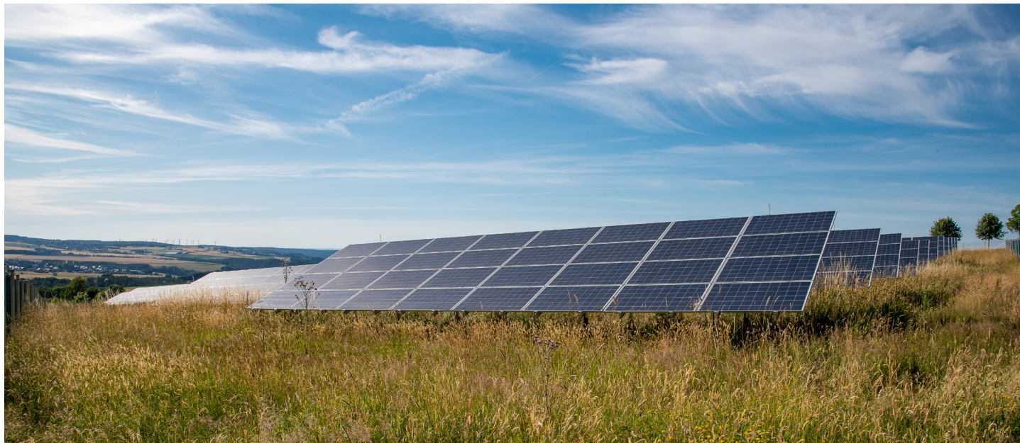
©ABO Wind - parc photovoltaïque de Malborn
