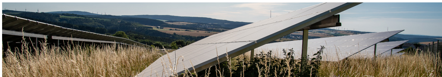
Parc photovoltaïque de Malborn (Allemagne)
