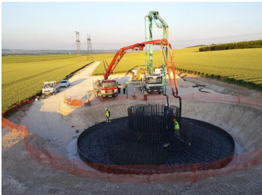
Construction d'une fondation d'éolienne
