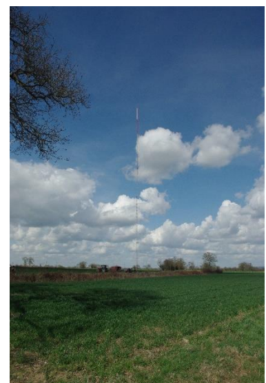
Exemple de mât de mesure sur site
