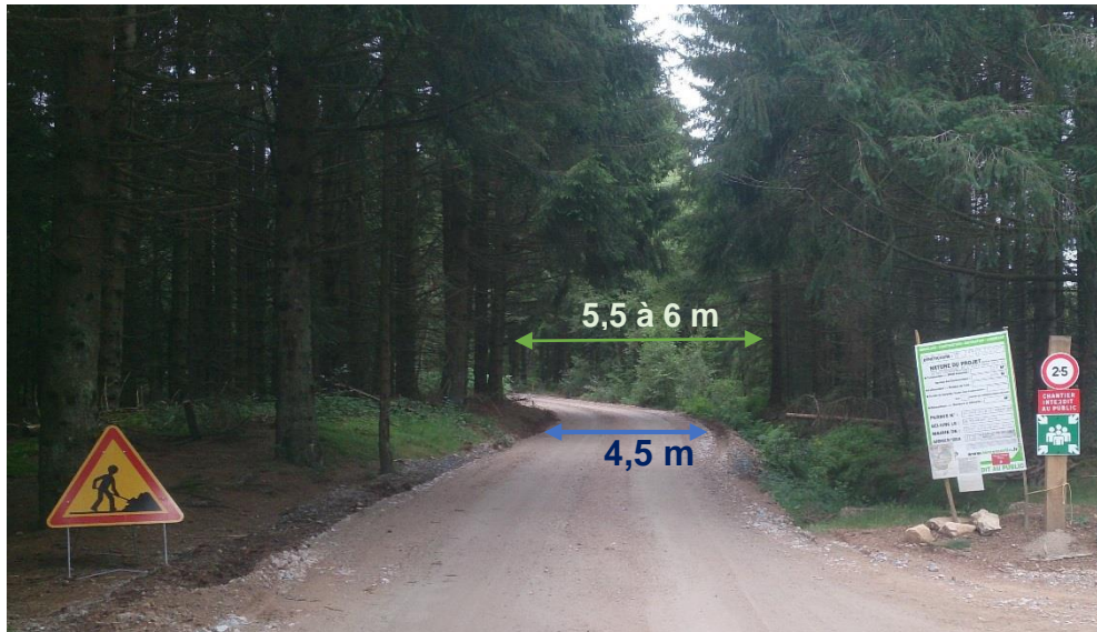
Piste forestière aménagée pour les accès du parc de Saint-Nicolas-des-Biefs (Allier)
