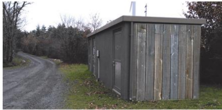
Illustration 42 : Bardage bois vertical des pignons aveugles du poste de livraison
