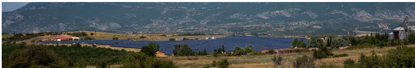
Parc photovoltaïque de Kossos (Grèce)
