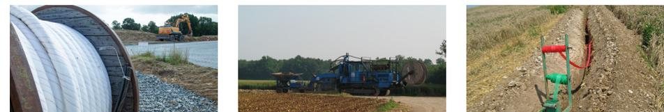
Des tranchées sont creusées afin de poser les câbles qui relient les éoliennes entre elles. Un poste de livraison de l'énergie électrique est installé sur le site. Les équipements sont ensuite raccordés à celui-ci.
