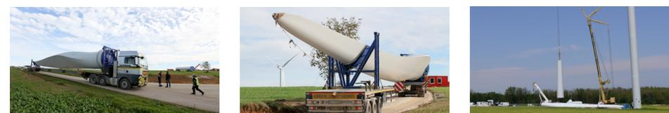
Le transport des différents composants de l'éolienne se fait par convois exceptionnels. Le montage des composants (mât, nacelle puis pales) est réalisé grâce à une grue de levage de très forte capacité. C'est la dernière phase du chantier avant la mise en service du parc.
