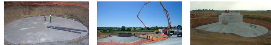
Cela passe par des travaux de terrassement et de renforcement de sol si nécessaire. Le ferrailage de fondation et la section d'ancrage sont ensuite mis en place avant le bétonnage de la fondation. Enfin, la terre est remblayée jusqu'à la base du mât de l'éolienne.
