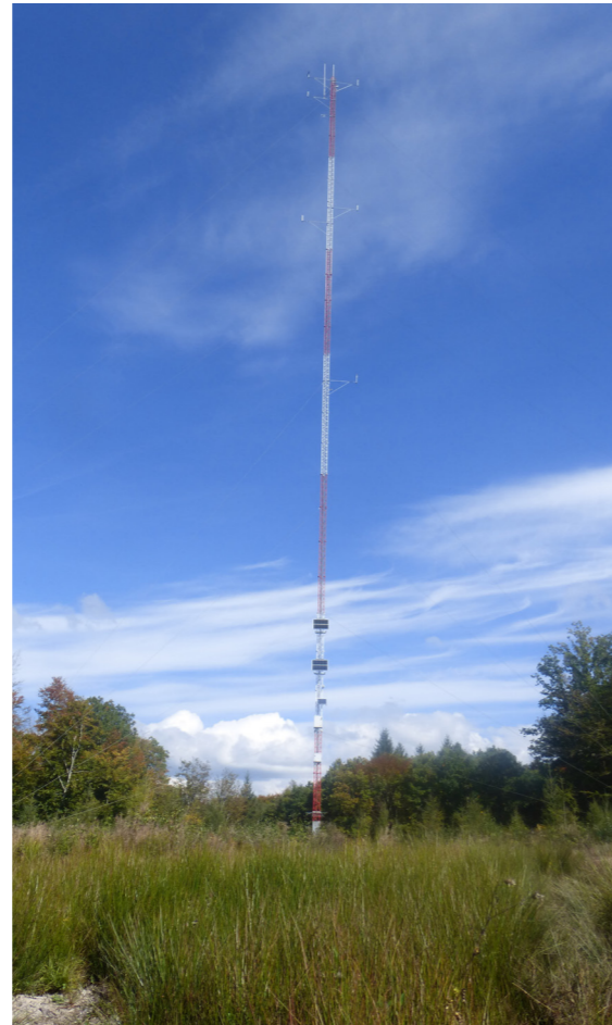
Mât de mesure sur zone d'étude
