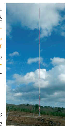
Exemple de mât de mesure monté par ABO Wind sur une zone d'étude
