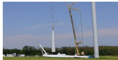
Le transport des différents composants de l'éolienne se fait par convois exceptionnels. Le montage des composants (mât, nacelle puis pales) est réalisé grâce à une grue de levage de très forte capacité. C'est la dernière phase du chantier avant la mise en service du parc.
