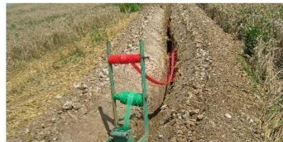
Des tranchées sont creusées afin de poser les câbles qui relient les éoliennes entre elles. Un poste de livraison de l'énergie électrique est installé sur le site. Les équipements sont ensuite raccordés à celui-ci.
