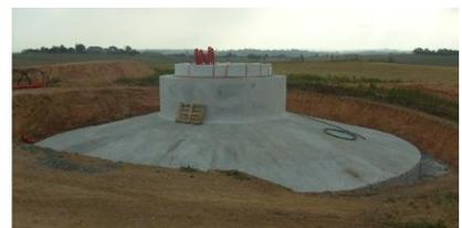
Cela passe par des travaux de terrassement et de renforcement de sol si nécessaire. Le ferrailage de fondation et la section d'ancrage sont ensuite mis en place avant le bétonnage de la fondation. Enfin, la terre est remblayée jusqu'à la base du mât de l'éolienne.
