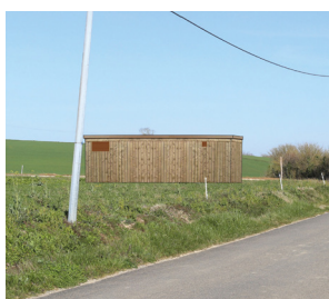
Intégration du poste de livraison, vue depuis la D88
