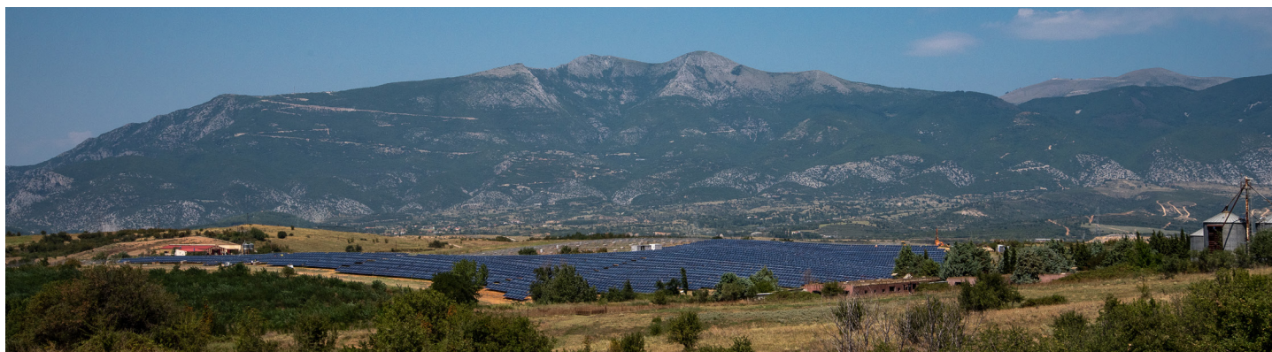
Parc photovoltaïque de Kossos (Grèce)
