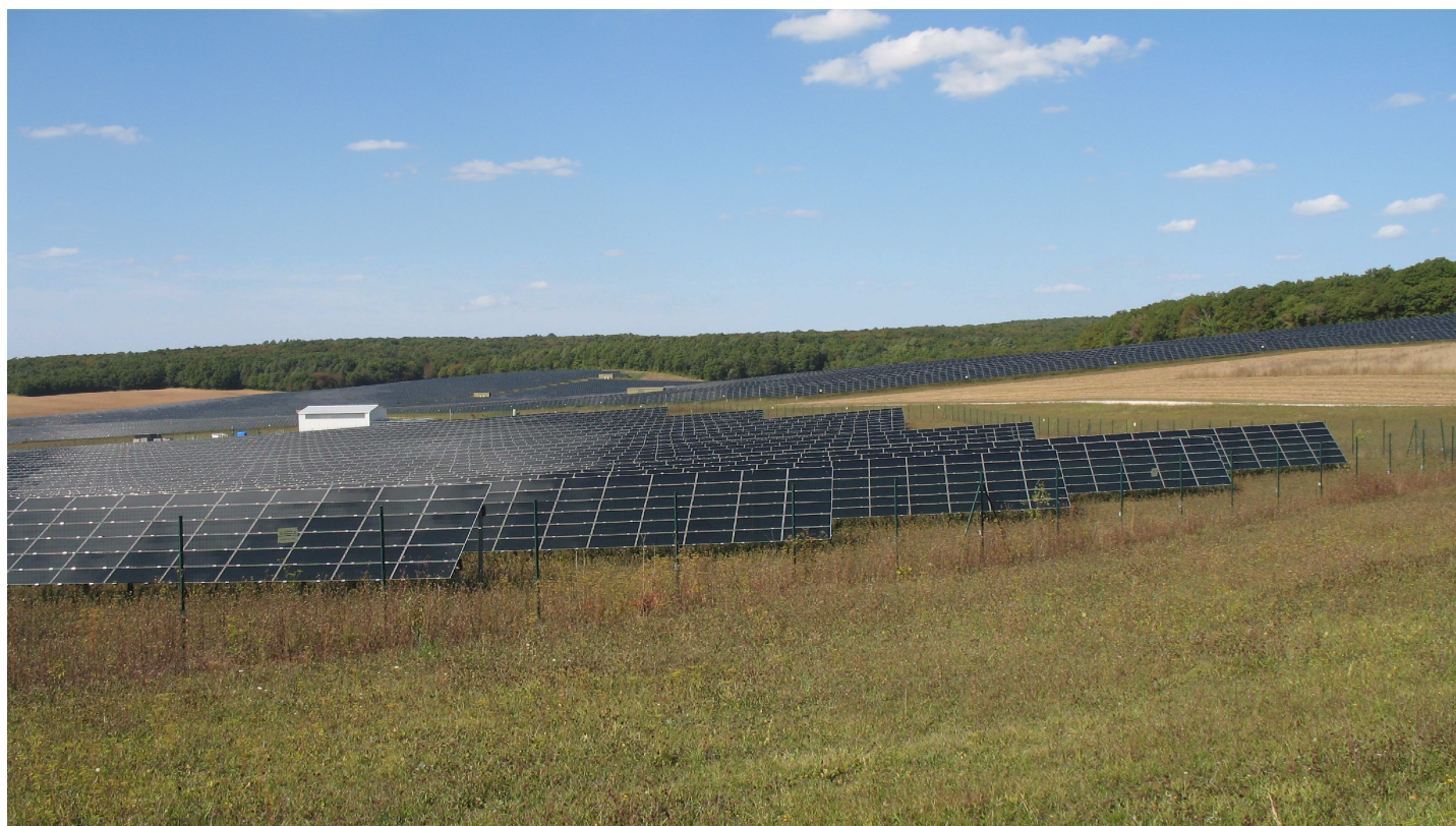
Centrale solaire photovoltaïque au sol de Massangis (plus de 100 h et 56 MW)
