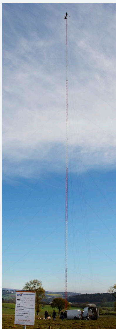
Photo d'un mât de mesure
