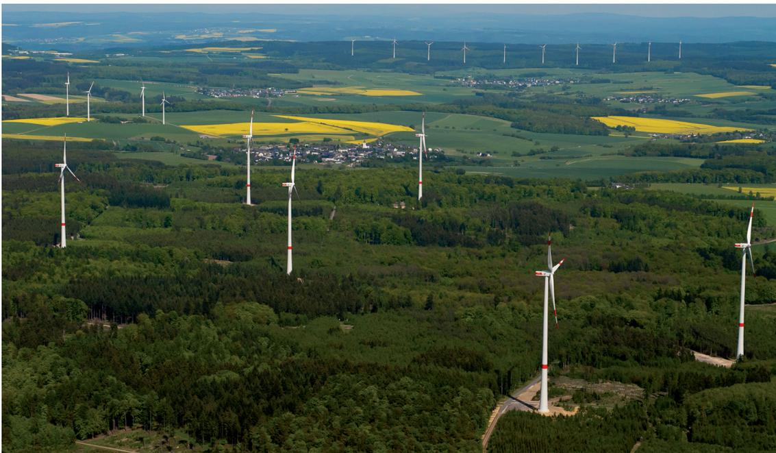
*Le parc éolien de Klosterkumbd, qu'ABO Wind a construit dans le massif de Hunsrück en Rhénanie Palatinat, est novateur pour le développement de parcs éoliens en milieux boisés. Les 6 éoliennes Repower de type 3.4M104 avec une capacité de production de chacune 3,4 MW produisent chaque année environ 39 millions de kWh d'électricité. Cela correspond au besoin de plus de 11.000 foyers.*
