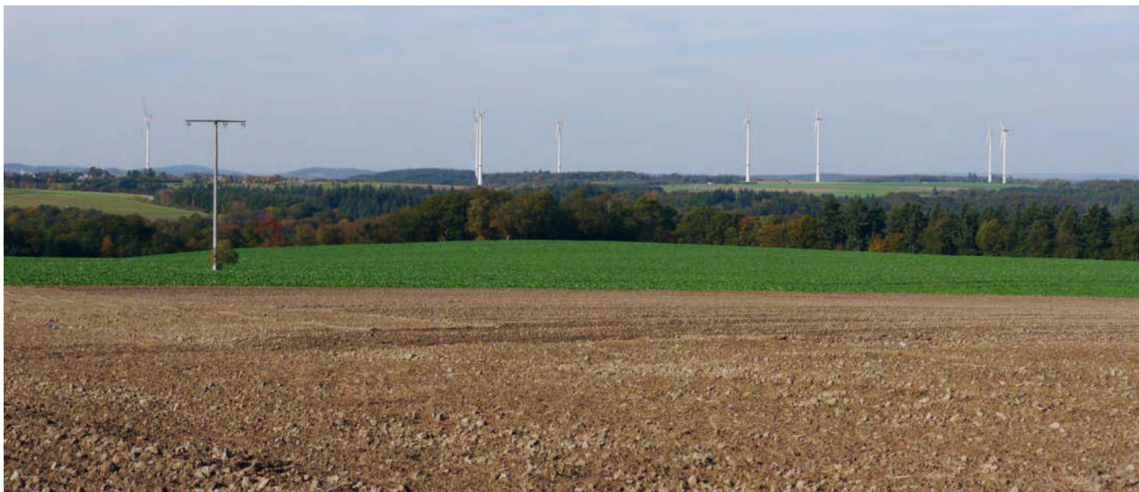
Nachher: Fotoaufnahme des errichteten Windparks, aufgenommen im Oktober 2019
