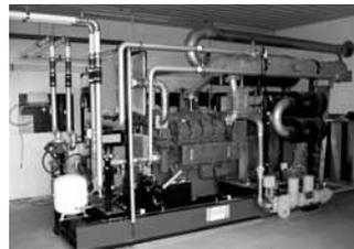
Das Biogas wird in einem Blockheizkraftwerk verbrannt, um Strom und Wärme zu erzeugen. Aufgrund der im EEG zugesicherten Vergütung wird der Strom im Regelfall ins öffentliche Netz eingespeist. Mit einem kleineren Teil der
