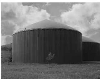
Zentraler Baustein einer Biogasanlage ist ihr Reaktor, der sogenannte Fermenter, in dem organische Substanz abgebaut wird. Der Fermenter besteht im Wesentlichen aus einem gasdicht abgeschlossenen und beheizbaren Behälter aus Stahl oder Stahlbeton.
