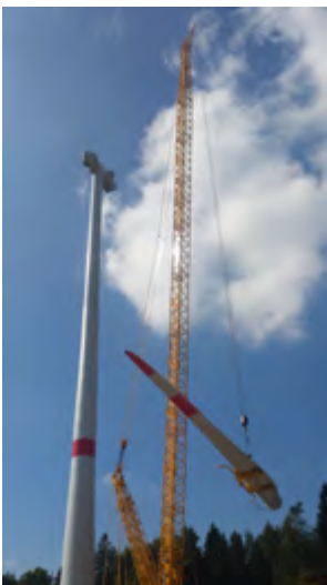
Die drei Rotorblätter werden nacheinander nach oben befördert. Nachdem ein Rotorblatt montiert ist, wird der Rotor so weit gedreht, dass das nächste ebenfalls horizontal angeschraubt werden kann.
