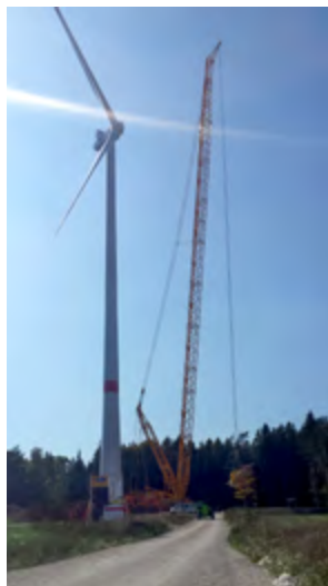
Die drei Rotorblätter werden nacheinander nach oben befördert. Nachdem ein Rotorblatt montiert ist, wird der Rotor so weit gedreht, dass das nächste ebenfalls horizontal angeschraubt werden kann.
