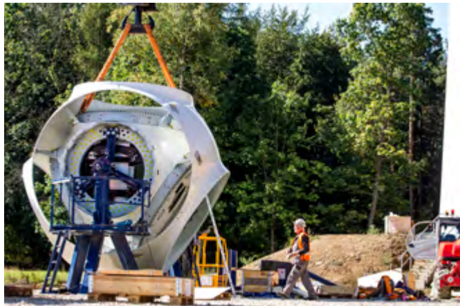
Monteure bereiten die Nabe zur Montage vor. An ihr werden später die Rotorblätter befestigt.
