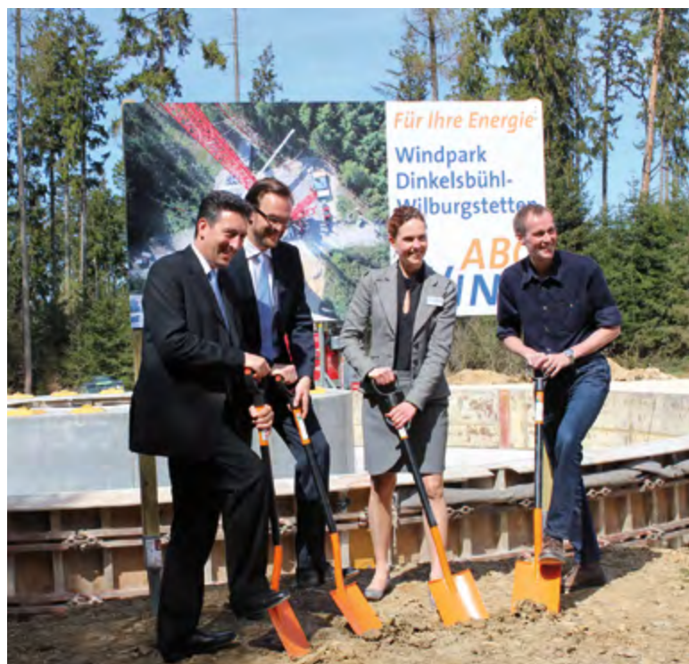
April 2015: Die Bürgermeister der beiden Gemeinden, der Projektentwickler ABO Wind und der Betreiber Stadtwerke Stuttgart sowie 30 Gäste und Unterstützer des Windparks feierten bei Sonnenschein den Baubeginn.
