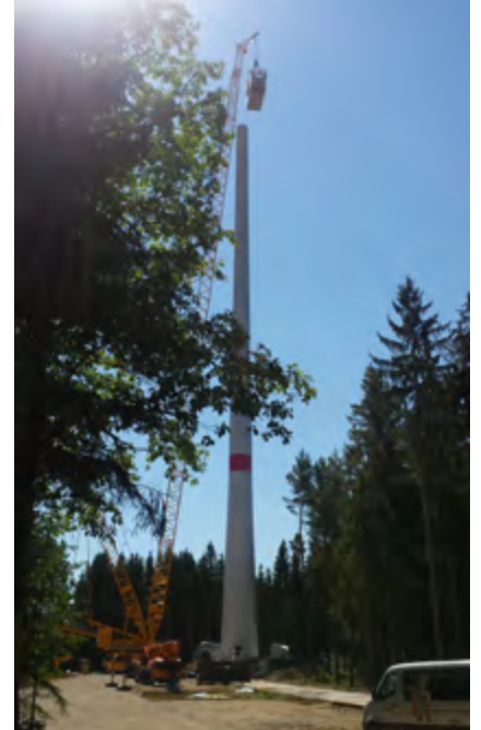
Das Maschinenhaus wird auf den Turm gesetzt.
