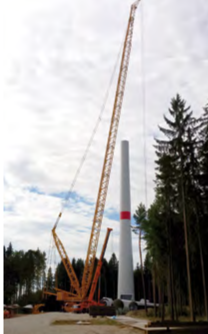
Auf den Betonturm werden zwei Stahlrohrsegmente montiert.
