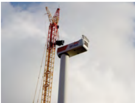
Der Triebstrang wird eingesetzt.
