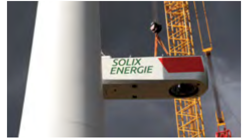
Die Abdeckung des Maschinenhauses wird abgehoben, um die Hebevorrichtung anzubringen.
