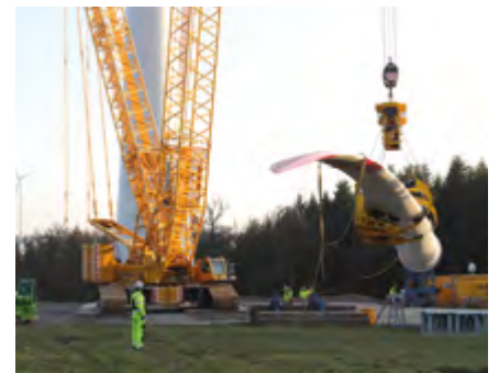
Die drei Rotorblätter werden mit einer Einzelblatt-Traverse nacheinander nach oben befördert.
