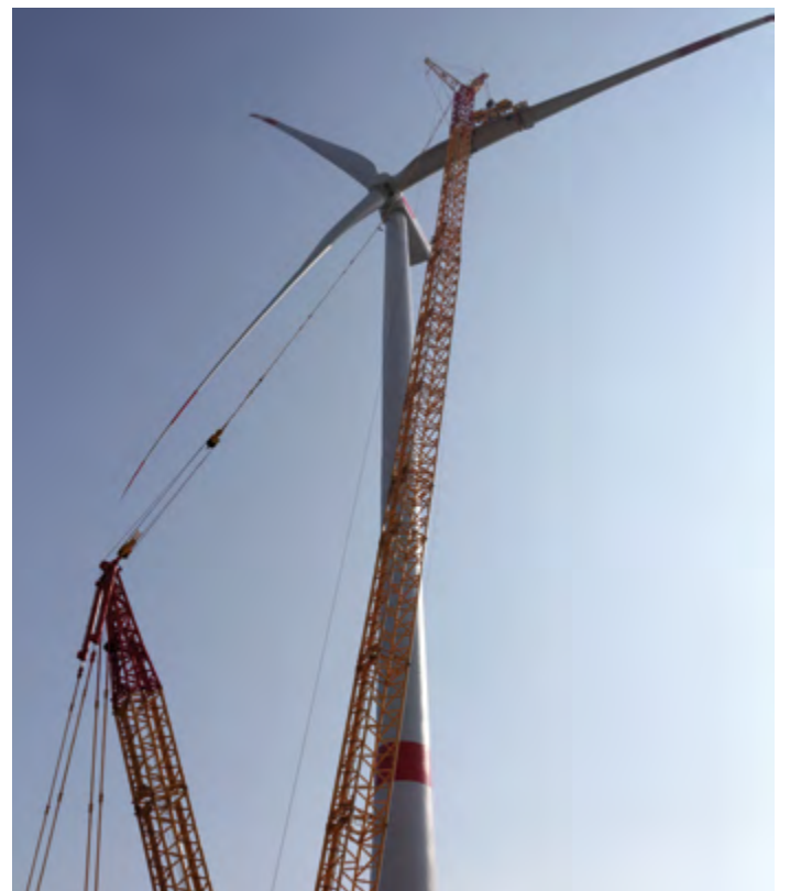
Nachdem ein Rotorblatt montiert ist, wird der Rotor so weit gedreht, dass das nächste ebenfalls horizontal angeschraubt werden kann.
