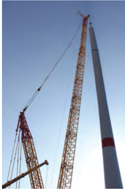
Das oberste Turmsegment wird montiert.
