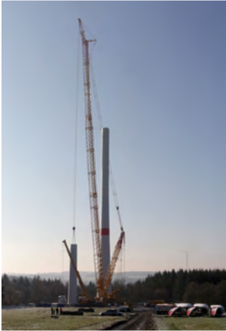
Auf der Baustelle im Januar 2016.
