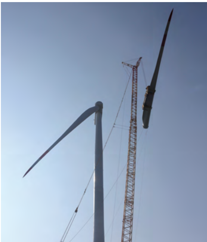
Nachdem ein Rotorblatt montiert ist, wird der Rotor so weit gedreht, dass das nächste ebenfalls horizontal angeschraubt werden kann.
