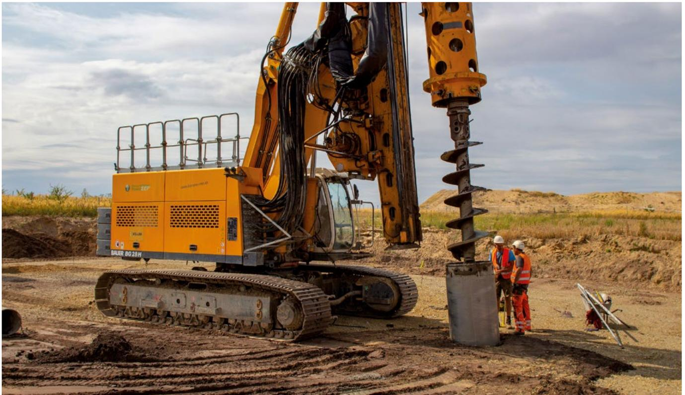
Die Baufachleute von ABO Wind errichten auch unter schwierigen Bedingungen stabile Fundamente für Windkraftanlagen. Das haben sie beim Bau des Windparks Forst Briesnig auf einem früheren Kohleabbaugebiet in der Lausitz unter Beweis gestellt.
