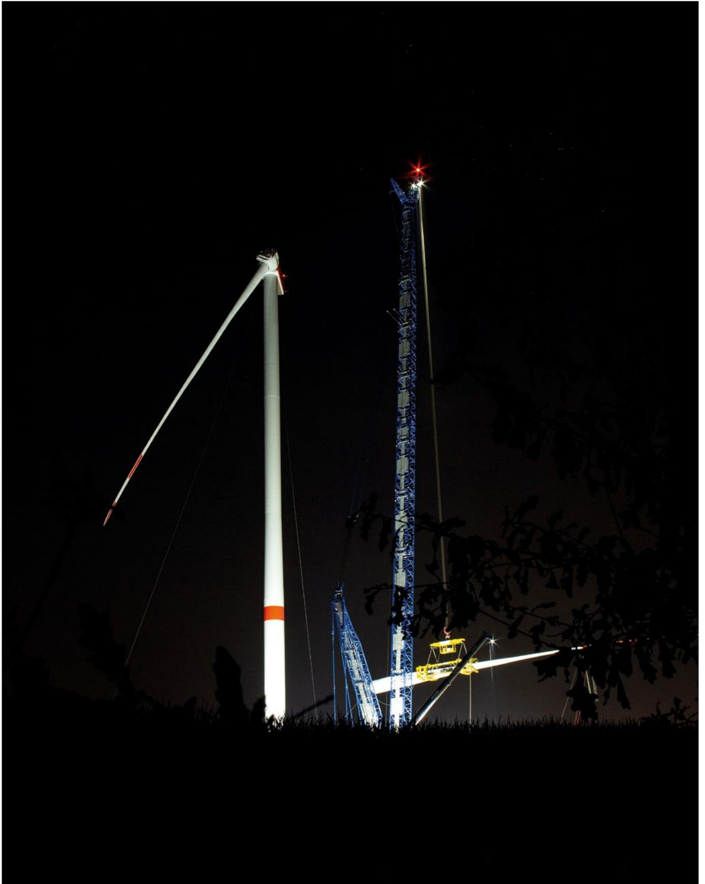
*Wertschöpfung durch Effizienz: In Wennerstorf südlich von Hamburg hat ABO Wind einen 15 Jahre alten Windpark mit vier Anlagen à jeweils 1,3 Megawatt abgebaut und durch zwei Nordex N149 ersetzt. Um eine Errichtung zur Messe „Windenergy“ 2018 in Hamburg zu ermöglichen, waren die Arbeiter Tag und Nacht im Einsatz. Messegästen bot Nordex Exkursionen zum von ABO Wind geplanten Leuchtturmprojekt.*
