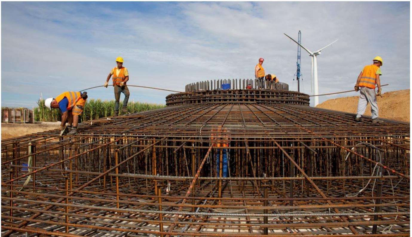
*Bau des Fundaments für den Windpark Wennerstorf: Bei dem Repowering-Projekt wurden vier ältere durch zwei moderne Anlagen ersetzt. Mit den beiden 4,5 Megawatt-Generatoren vom Typ Nordex N149 produziert der neue Windpark dreimal so viel Strom wie der Vorgänger.*
