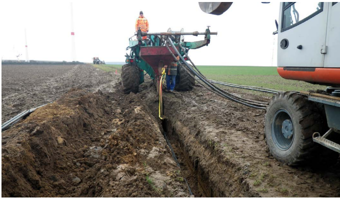
Das Kabelsystem wird entlang bestehender Wege verlegt.
