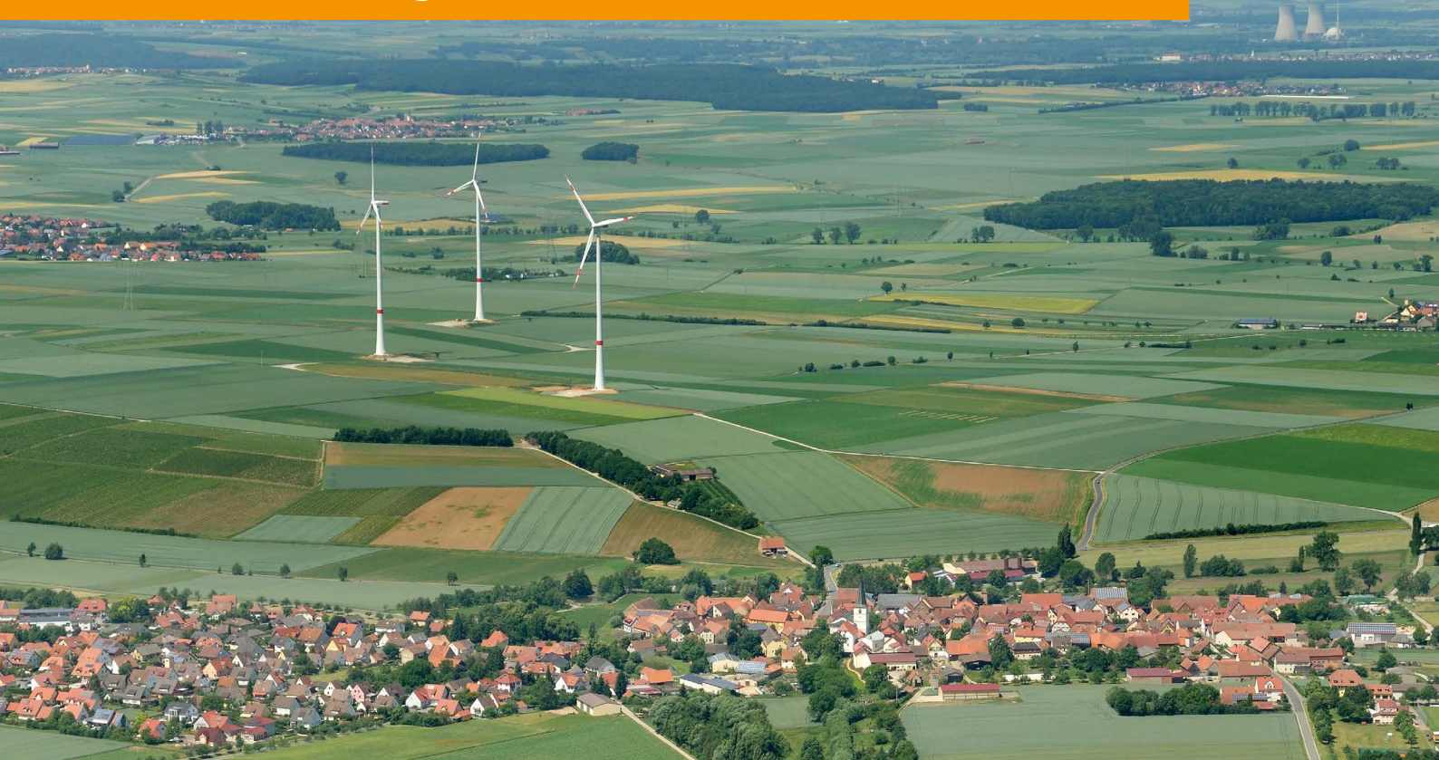
Die drei Anlagen des Windparks Brünnstadt, im Hintergrund das Atomkraftwerk Grafenrheinfeld.
