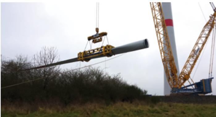
Um an Waldstandorten Platz und Rodungen zu sparen, werden die Rotorblätter einzeln an die bereits am Maschinenhaus befestigte Nabe montiert.
