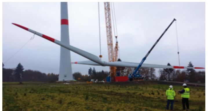
Im Offenland werden die Rotorblätter auf dem Boden an die Nabe montiert und als „Stern“ gezogen.
