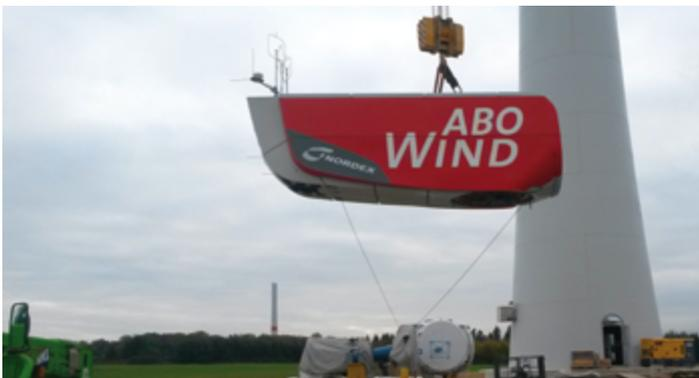
Dann wird das Maschinenhaus auf den Turm montiert.
