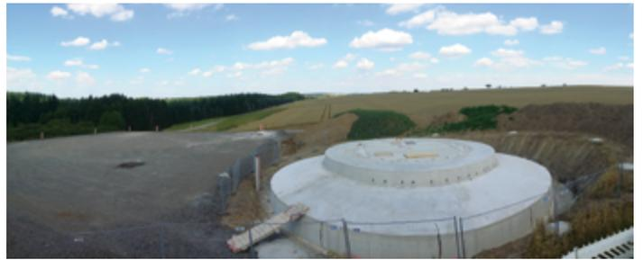
Mit 614 Kubikmetern Beton werden die Fundamente ausgegossen.
