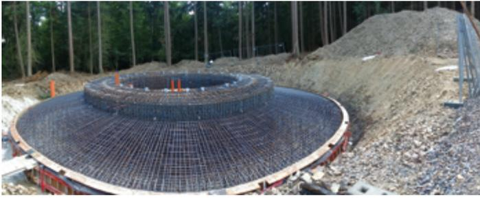
Die Fundamente haben einen Durchmesser von 21,5 Metern. Für die Bewehrung werden 83 Tonnen Stahl verbaut.
