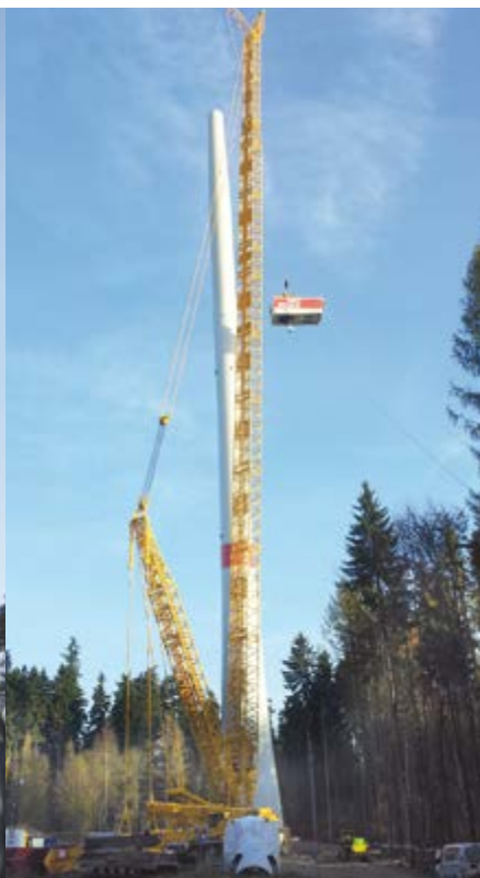
Die Fertigbetonteile werden nach und nach aufeinander gesetzt. Im Anschluss komplettieren zwei Stahlrohrsegmente und das Maschinenhaus den 139 Meter hohen Hybridturm.
