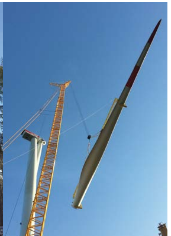
Die Rotorblätter werden einzeln an die Nabe montiert. Diese Methode ist platzsparend und reduziert den Flächenbedarf im Wald.
