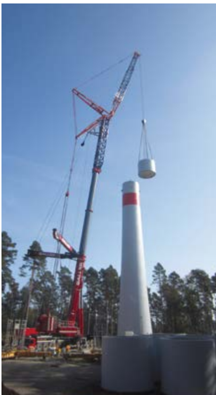
Die Fertigbetonteile werden nach und nach aufeinander gesetzt. Im Anschluss komplettieren zwei Stahlrohrsegmente und das Maschinenhaus den 139 Meter hohen Hybridturm.
