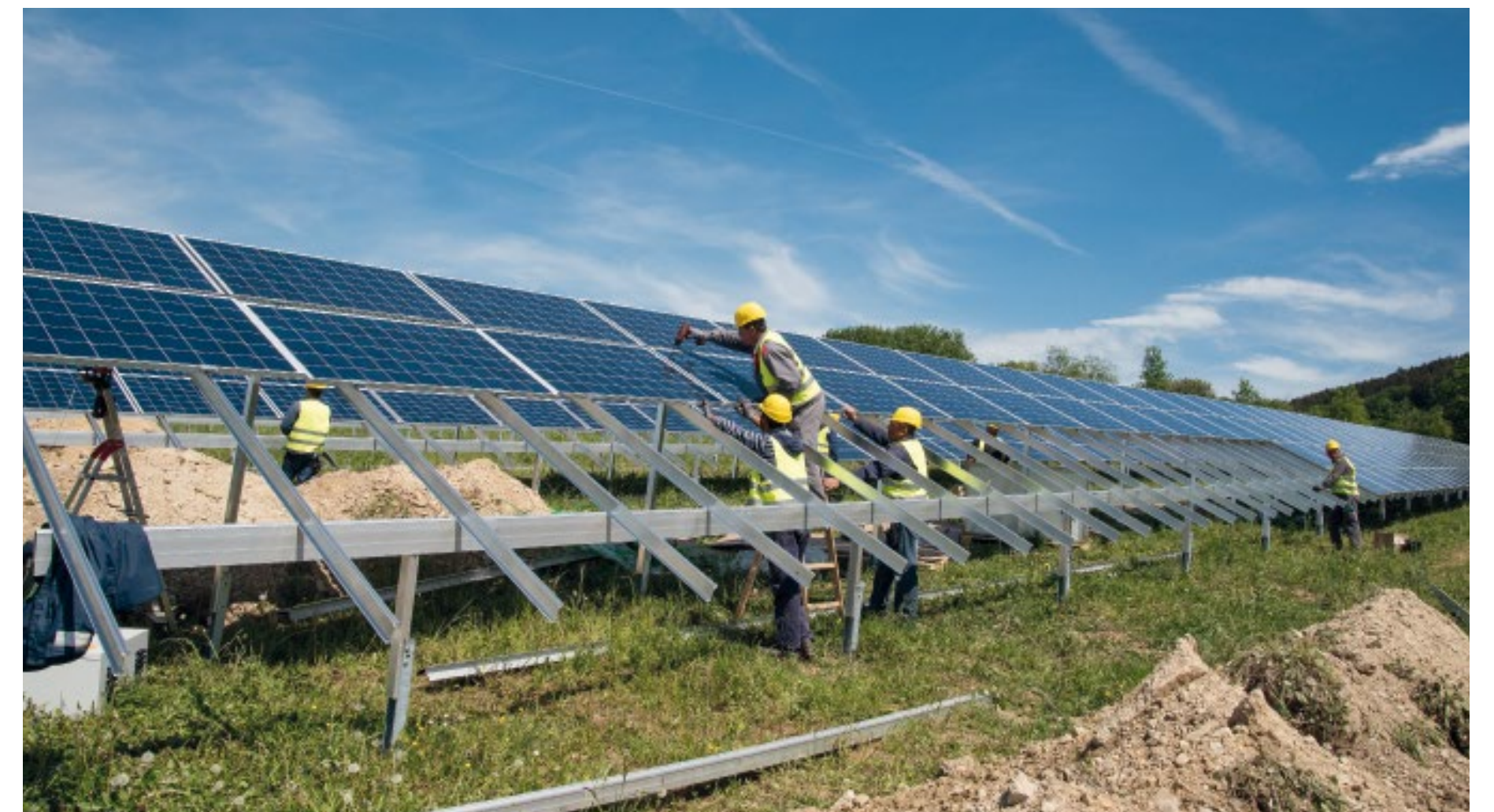
Montage PV-Module (PV-Anlage Malborn; 2018)
