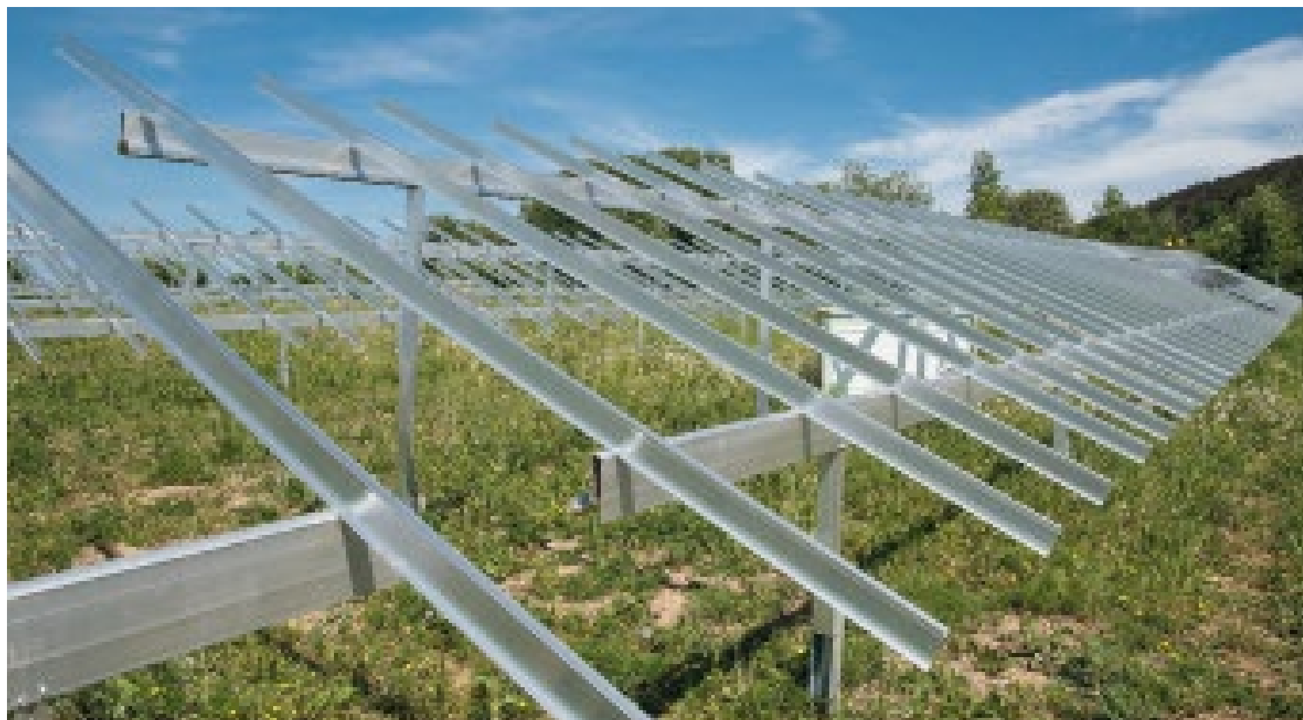
Tischmontage (PV-Anlage Malborn; 2018)
