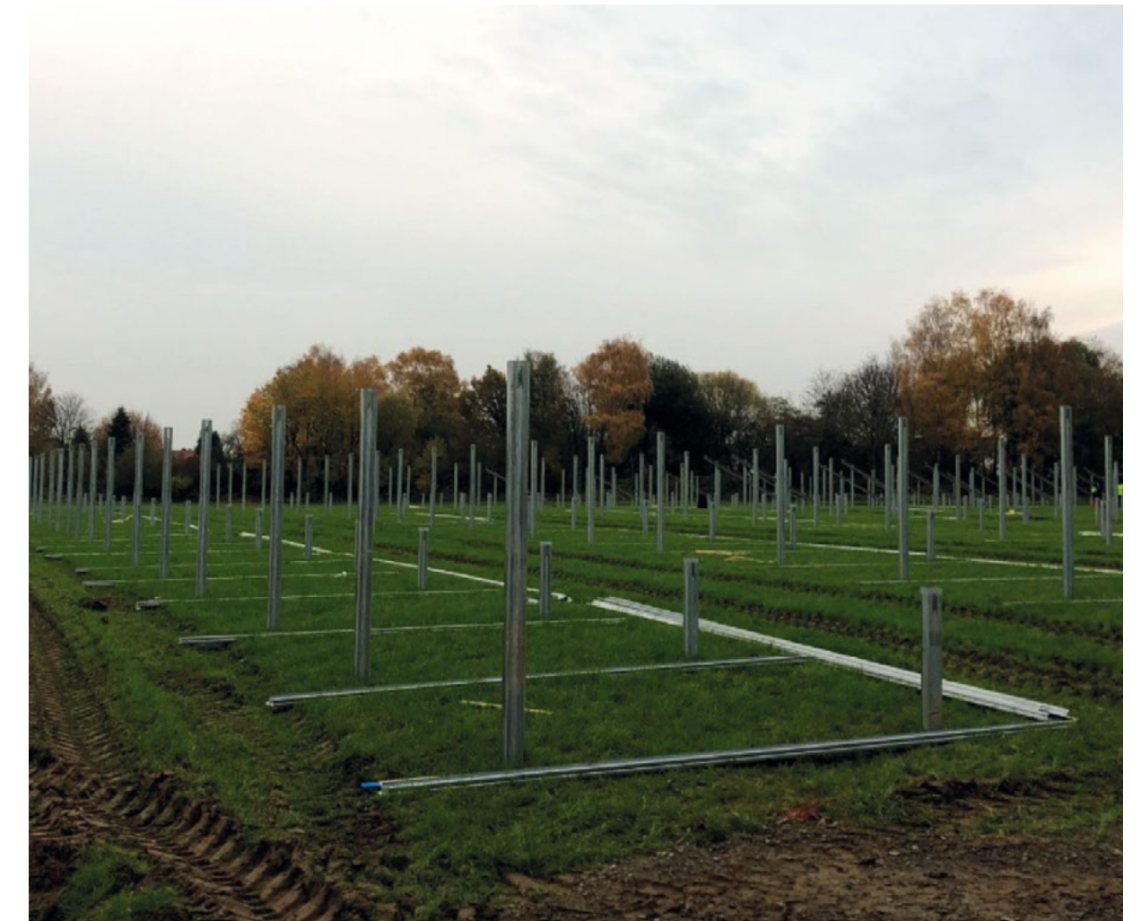
Gerammte Rammprofile Tiefe 1,40m (PV-Anlage Lemgo; 2019)
