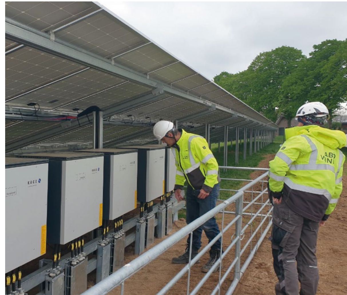
Inbetriebnahme Wechselrichter (PV-Anlage Kevelaer; 2020)
