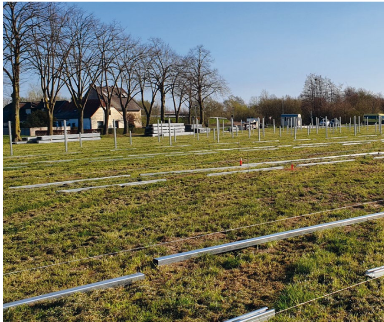
Rammvorbereitung Montage Unterkonstruktion (PV-Anlage Kevelaer; 2020)
