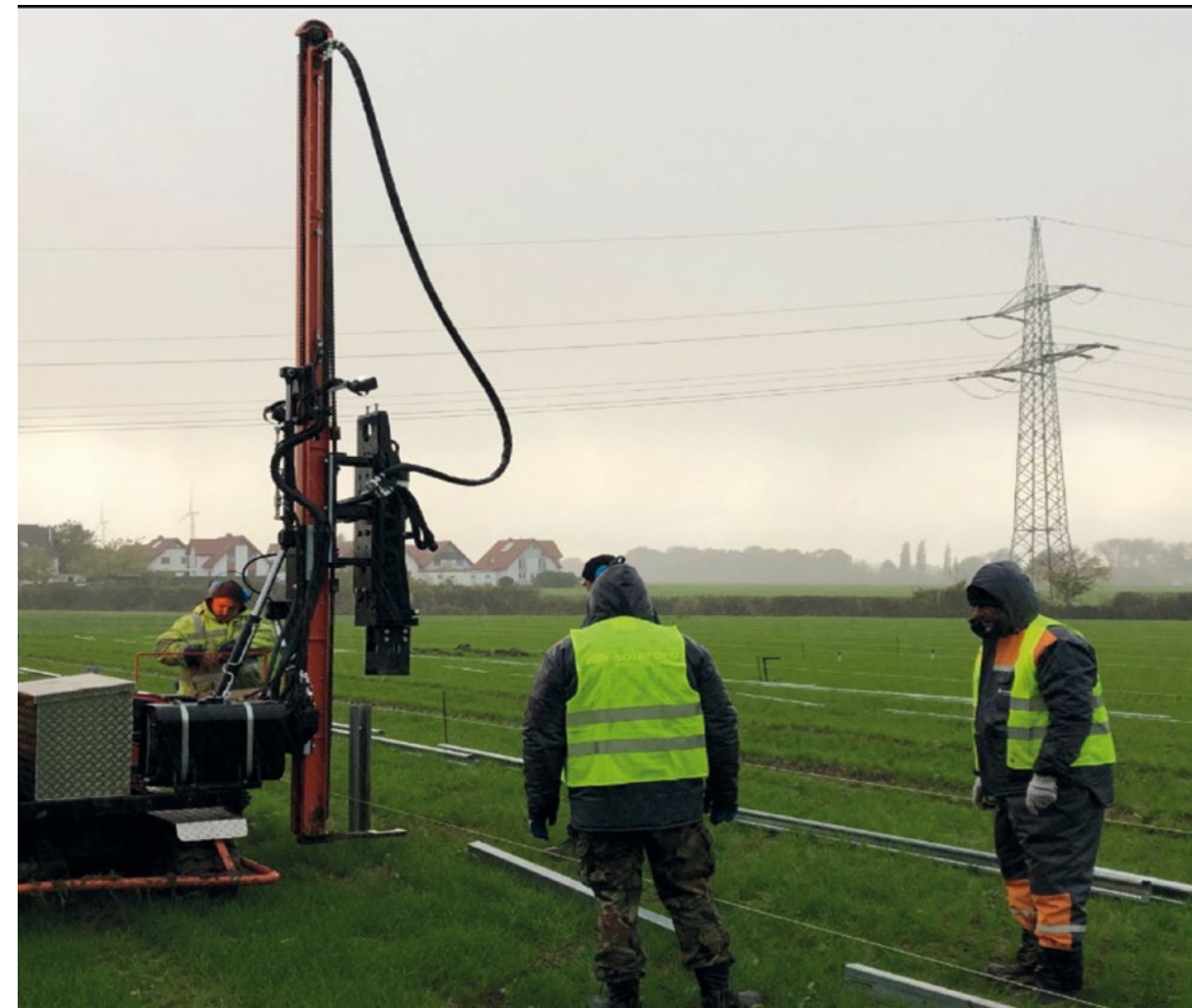
Rammmaschine (PV-Anlage Lemgo; 2019)
