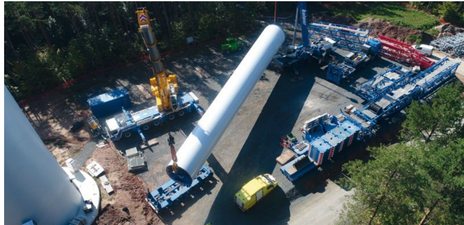
Der Stahlturm wird angeliefert.
