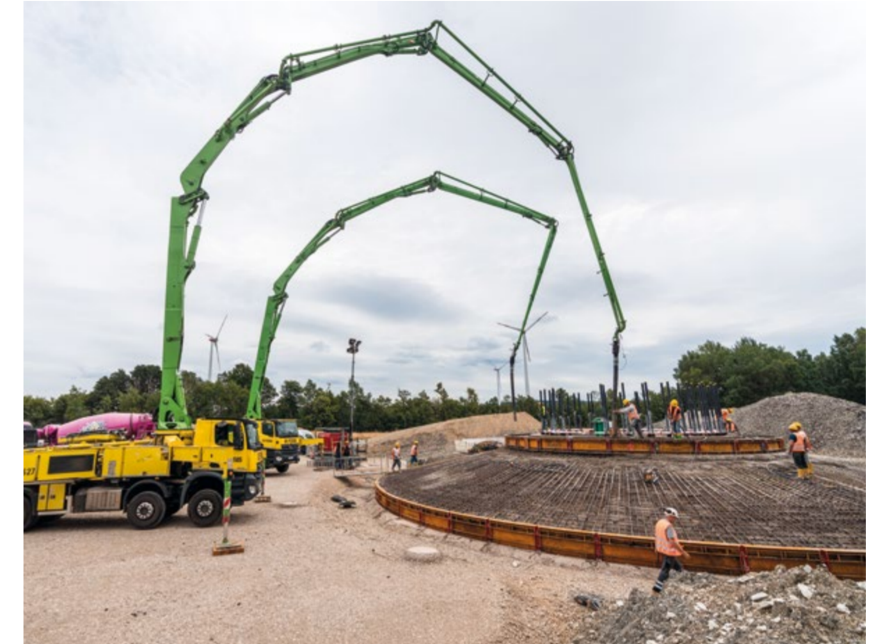
Betonage des Fundaments
