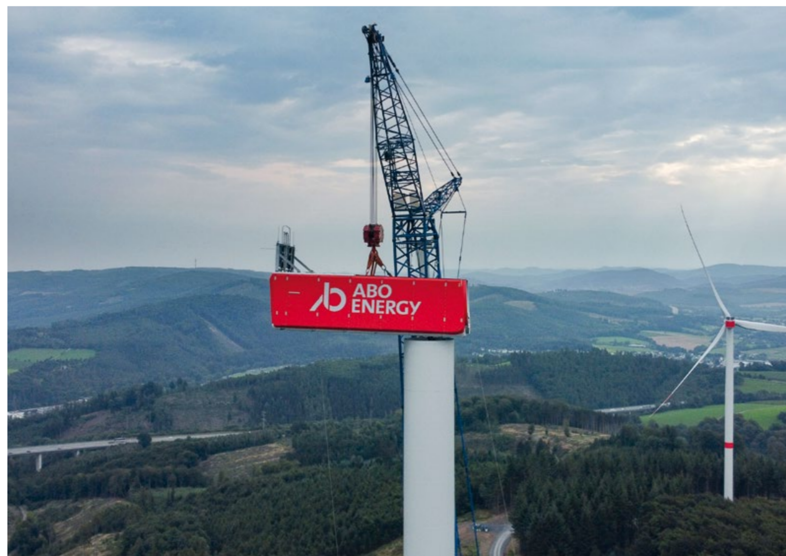
Montage des Maschinenhauses
