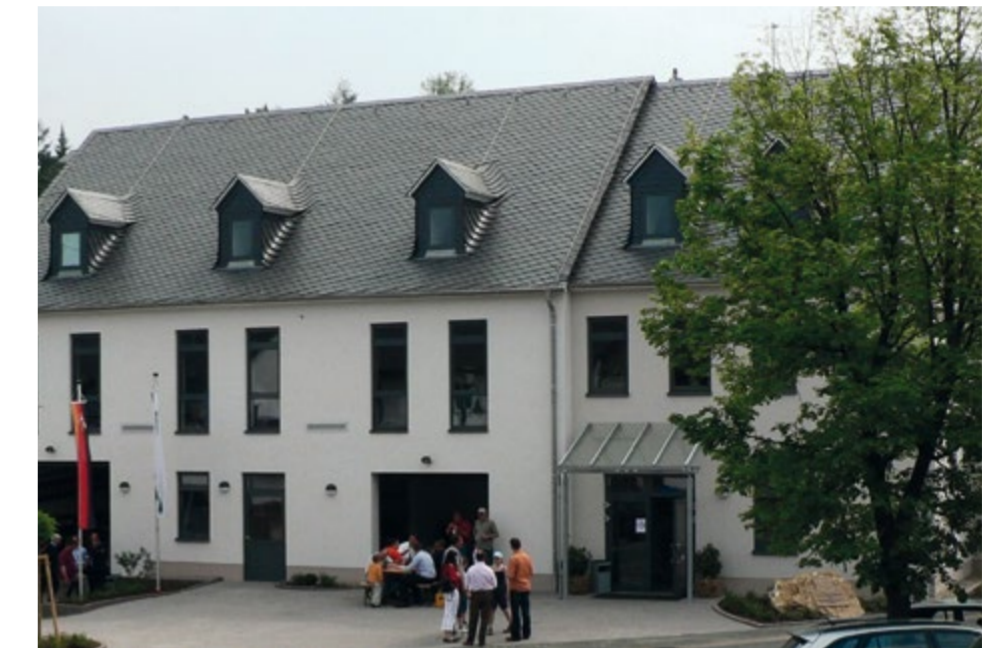
In Berglicht konnte dank den Einnahmen aus der Windkraft ein Dorfgemeinschaftshaus gebaut werden.
