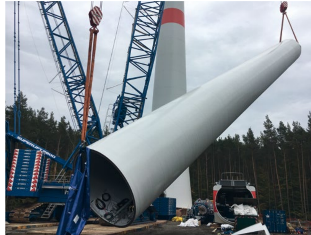
Montage eines Stahlturms
