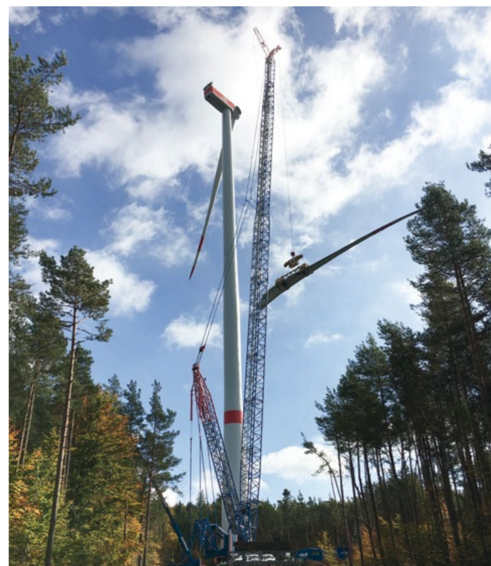
Einzeln werden die Rotorblätter an die Nabe montiert.
