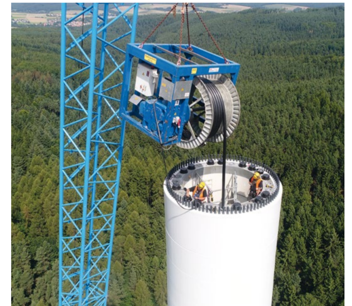
Ein Arbeitsplatz mit Ausblick
