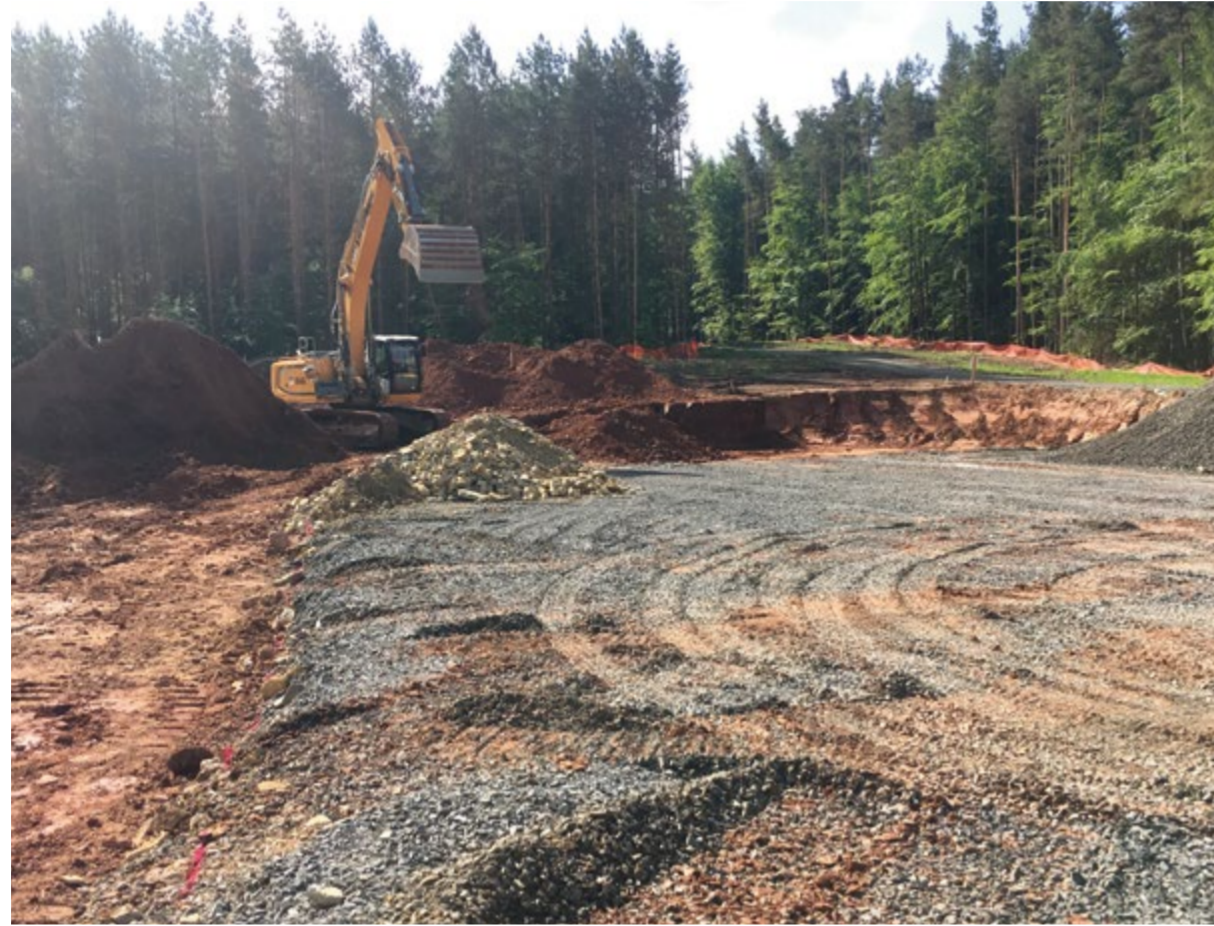
Der Standort wird für den Fundamentbau vorbereitet.
