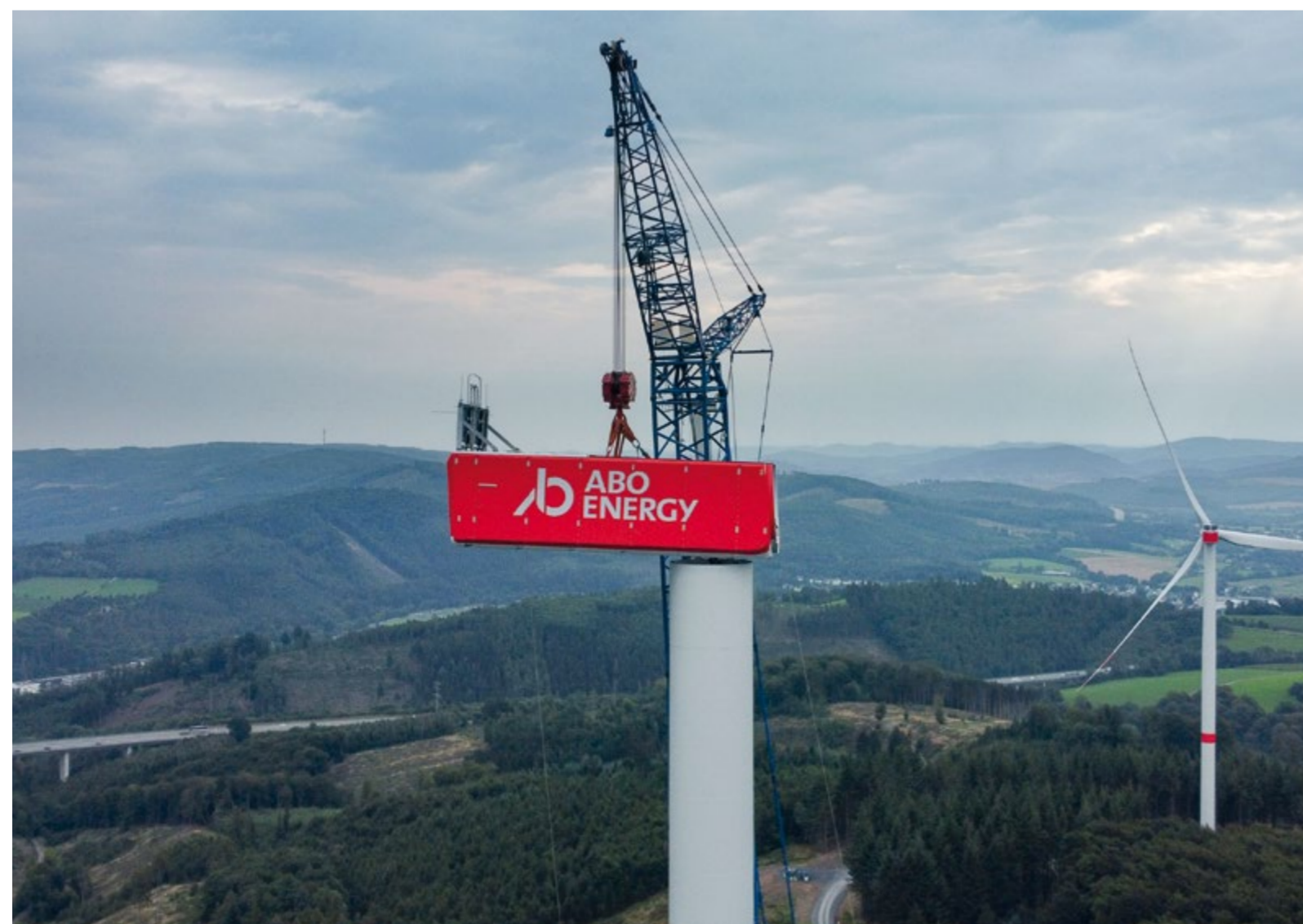
Montage des Maschinenhauses
