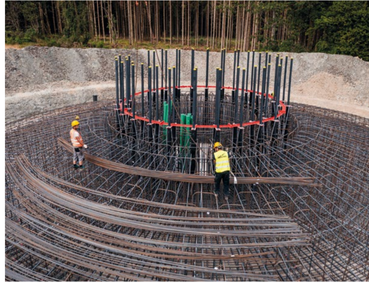
Der Fundamentkorb wird geflochten.
