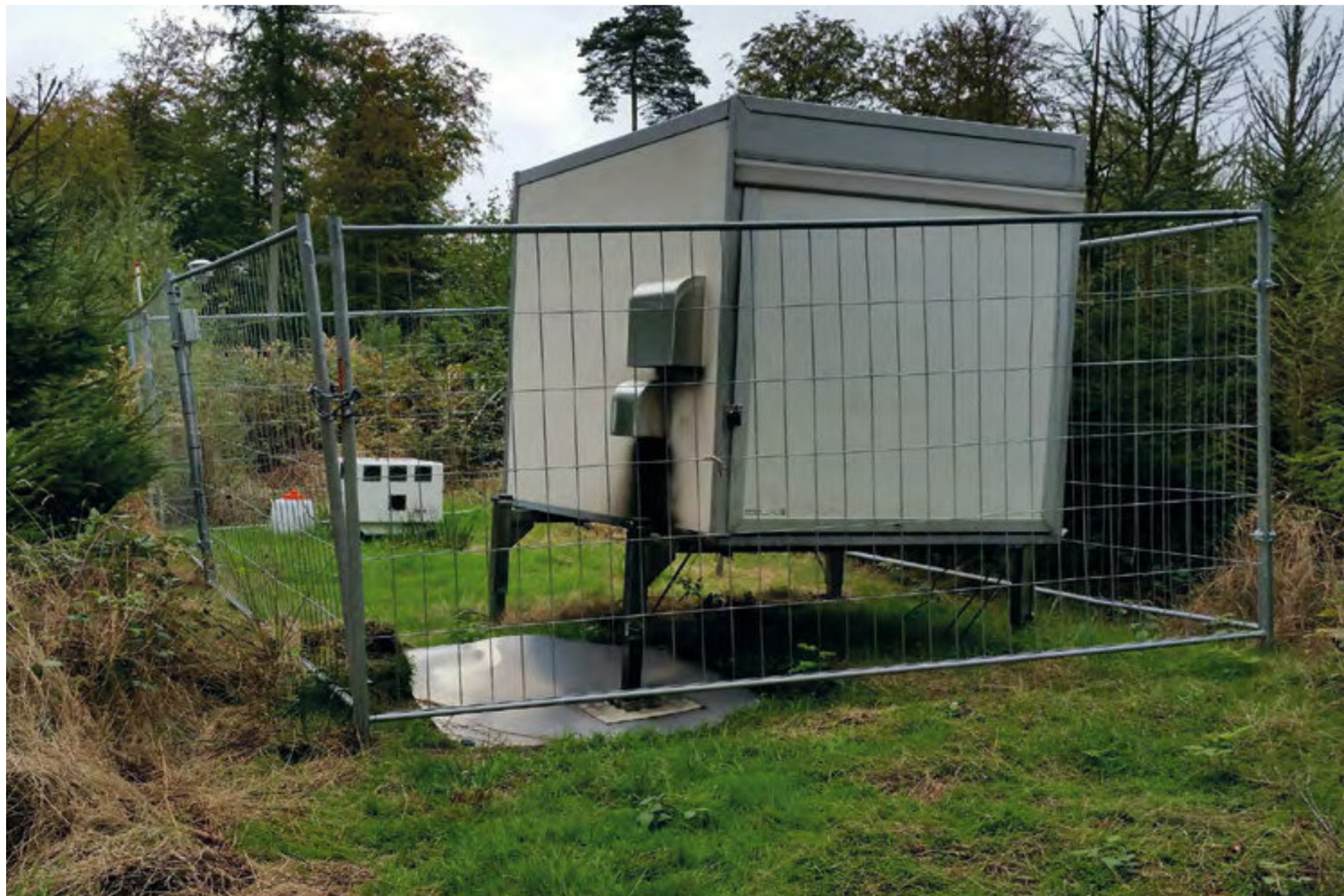
LiDAR-Messgerät im Transporter am Standort Nentershausen
