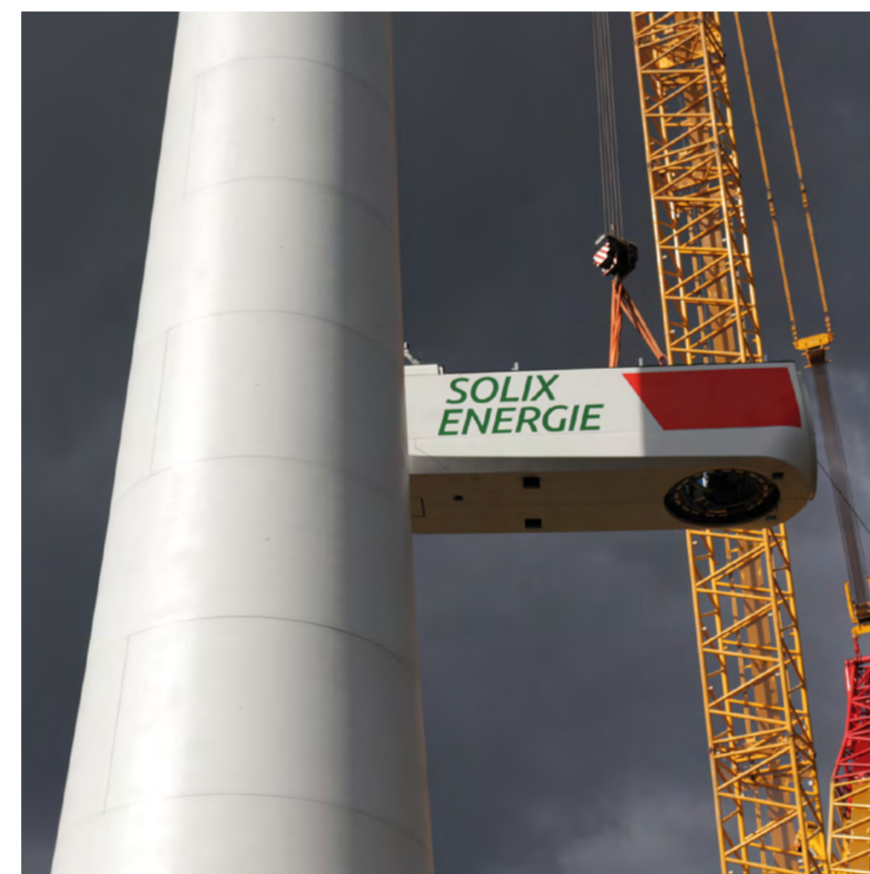
Errichtung der Anlage in Lahr im Frühjahr 2016
