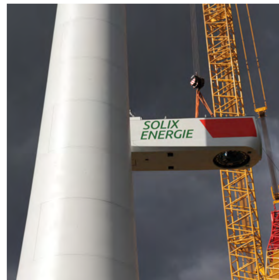
Errichtung der Anlage in Lahr im Frühjahr 2016
