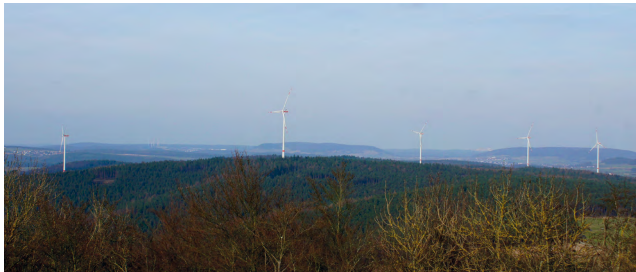
Nachher: Fotoaufnahme des errichteten Windparks
