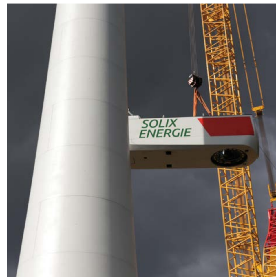
Errichtung der Anlage in Lahr im Frühjahr 2016
