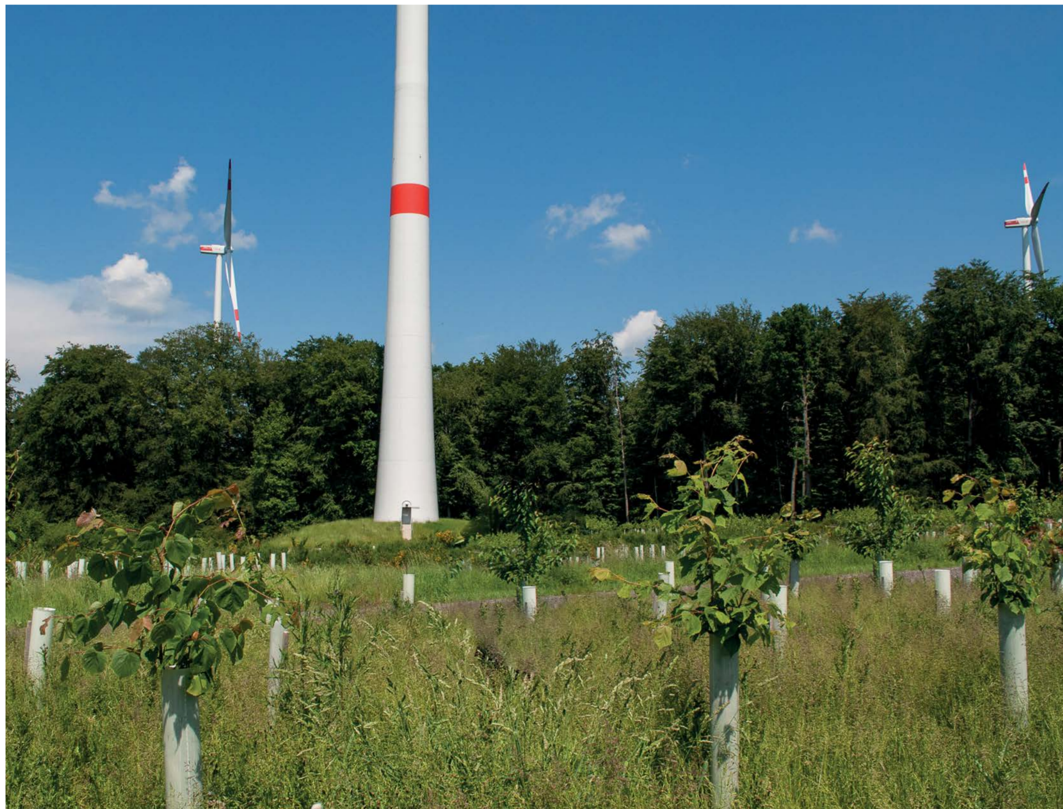
Der Windpark in Schnorbach entstand im monokulturell geprägten Wirtschaftswald. Im Zuge des Baus erfolgten Erstaufforstungen von Laubmischwäldern aus regionalen Gehölzen.
