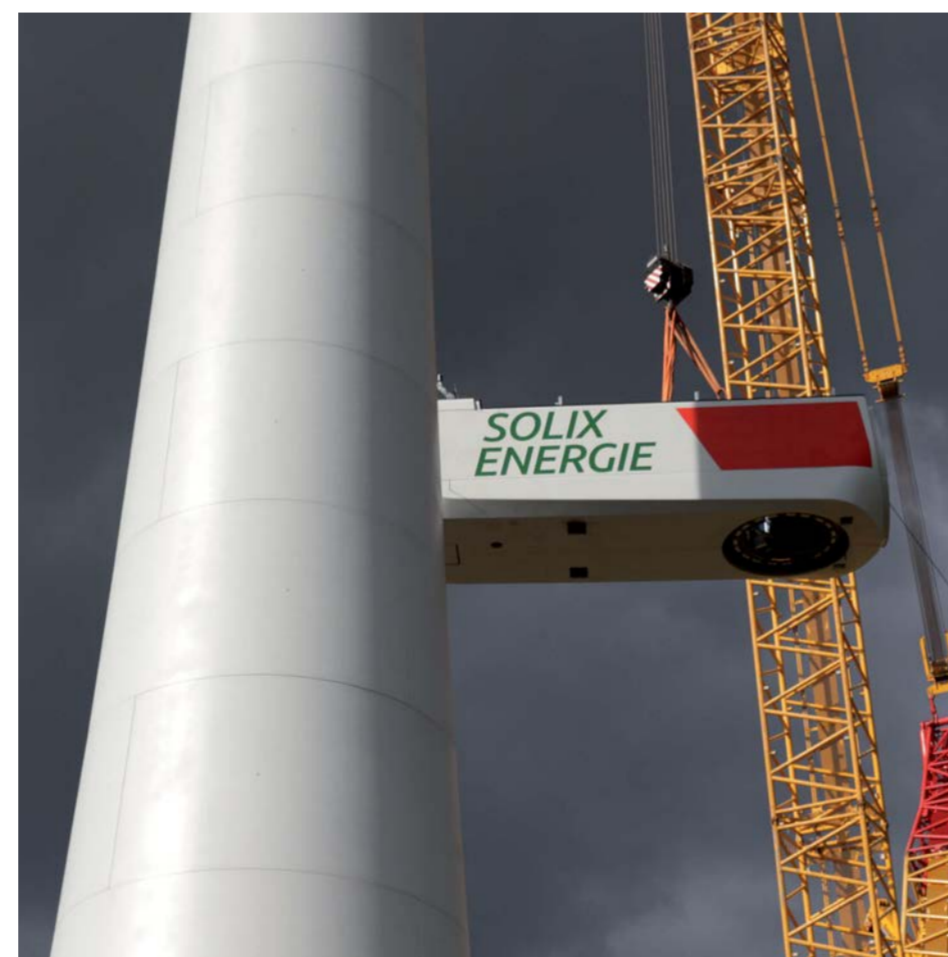
Errichtung der Anlage in Lahr im Frühjahr 2016
