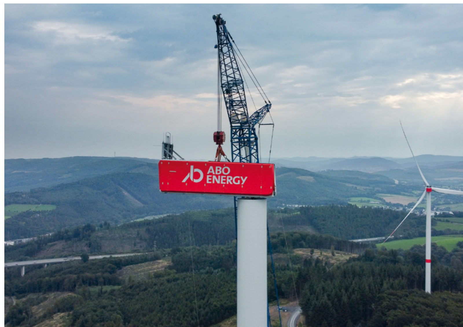
Montage des Maschinenhauses
