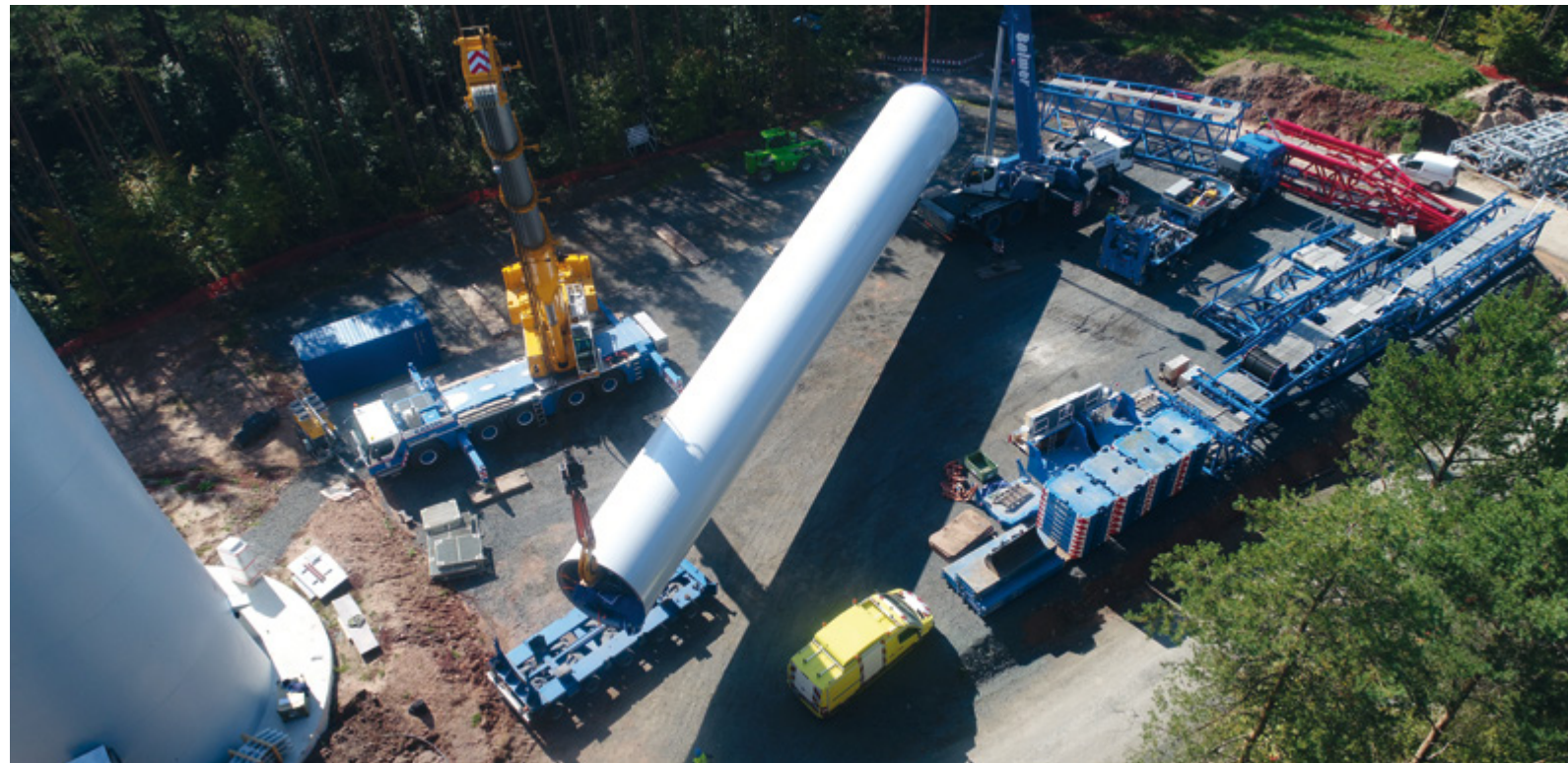
Der Stahlturm wird angeliefert.
