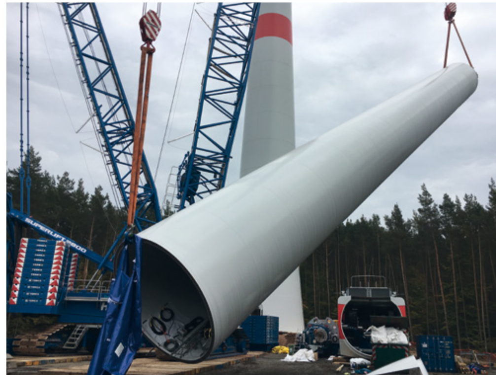
Montage eines Stahlturms
