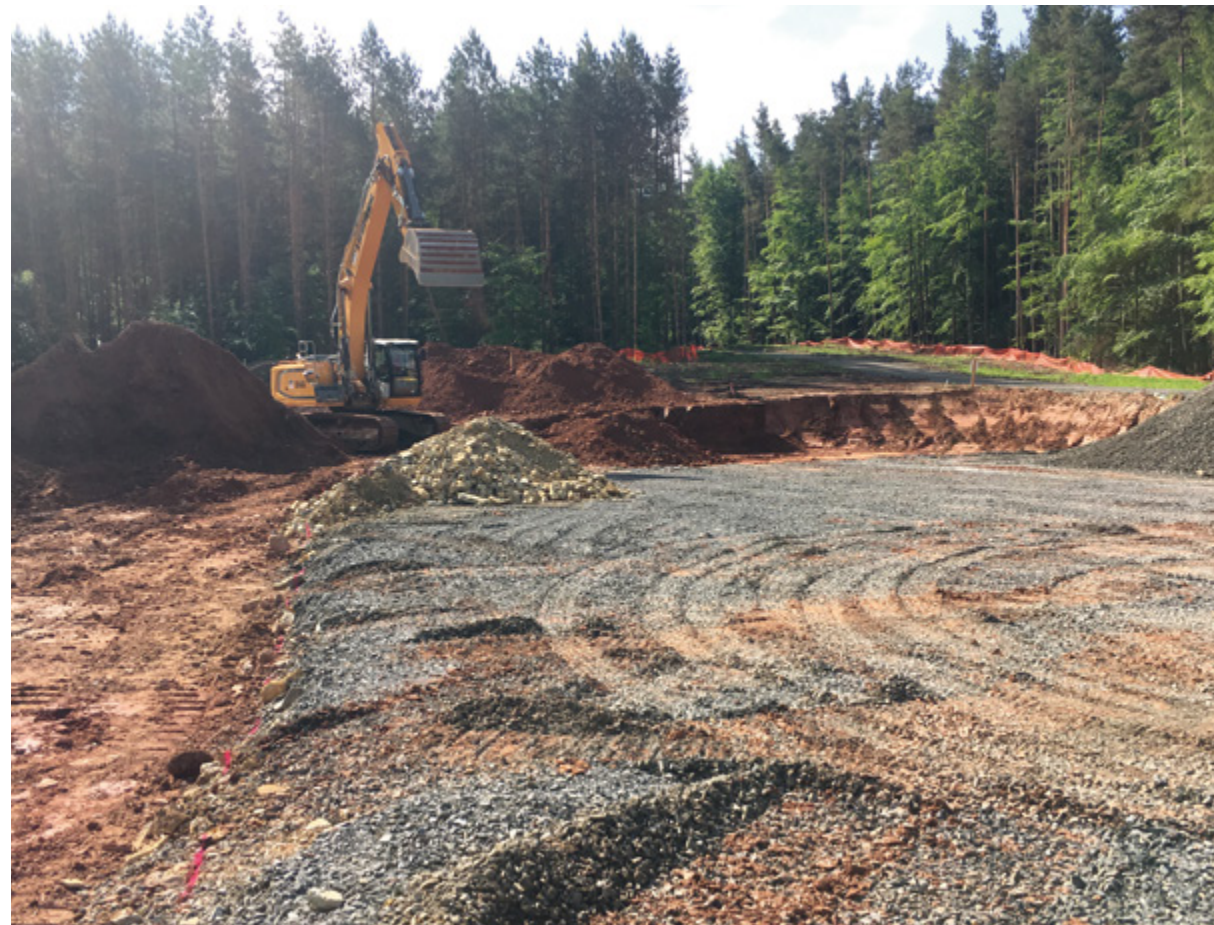
Der Standort wird für den Fundamentbau vorbereitet.
