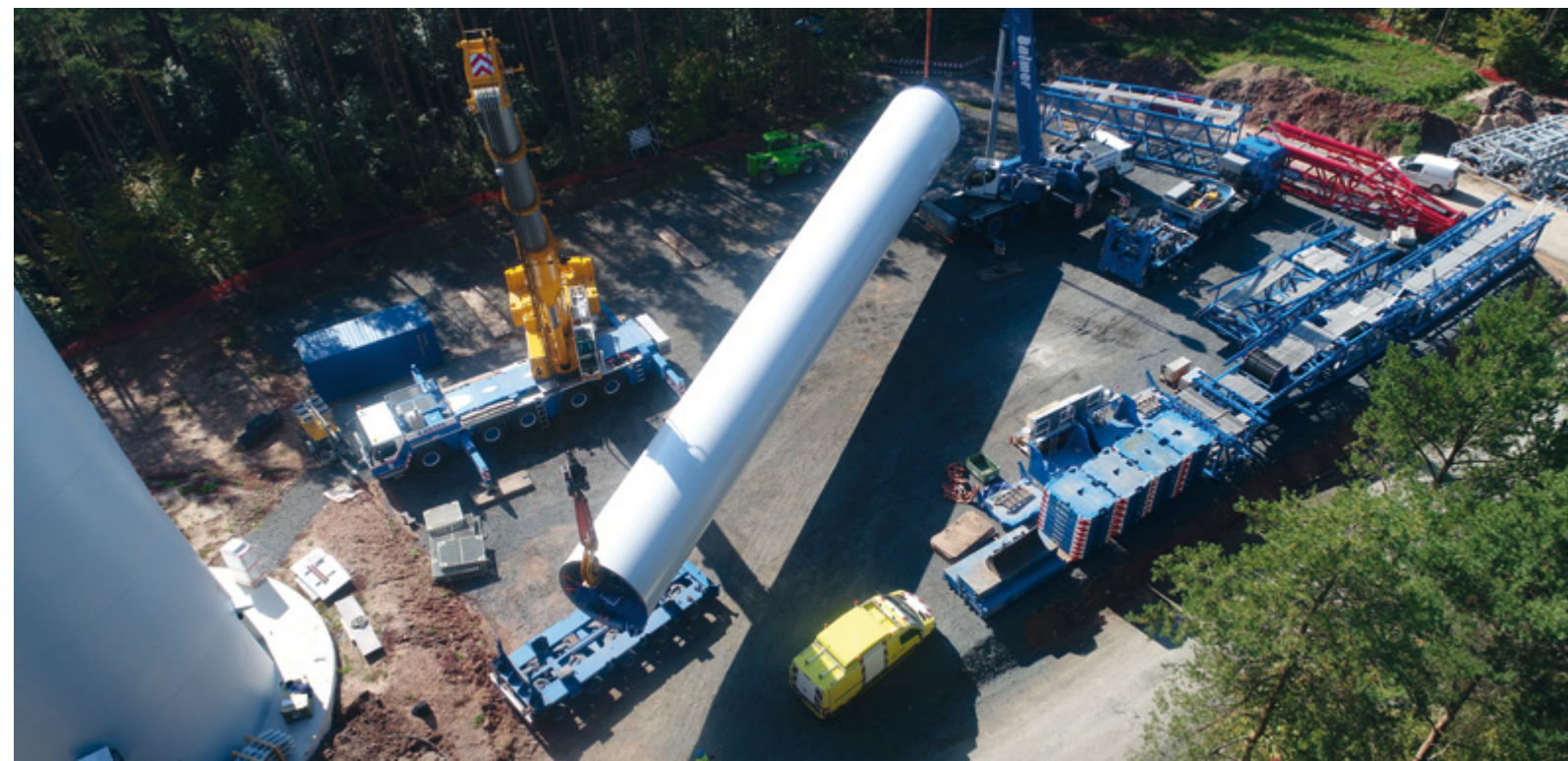
Der Stahlturm wird angeliefert.
