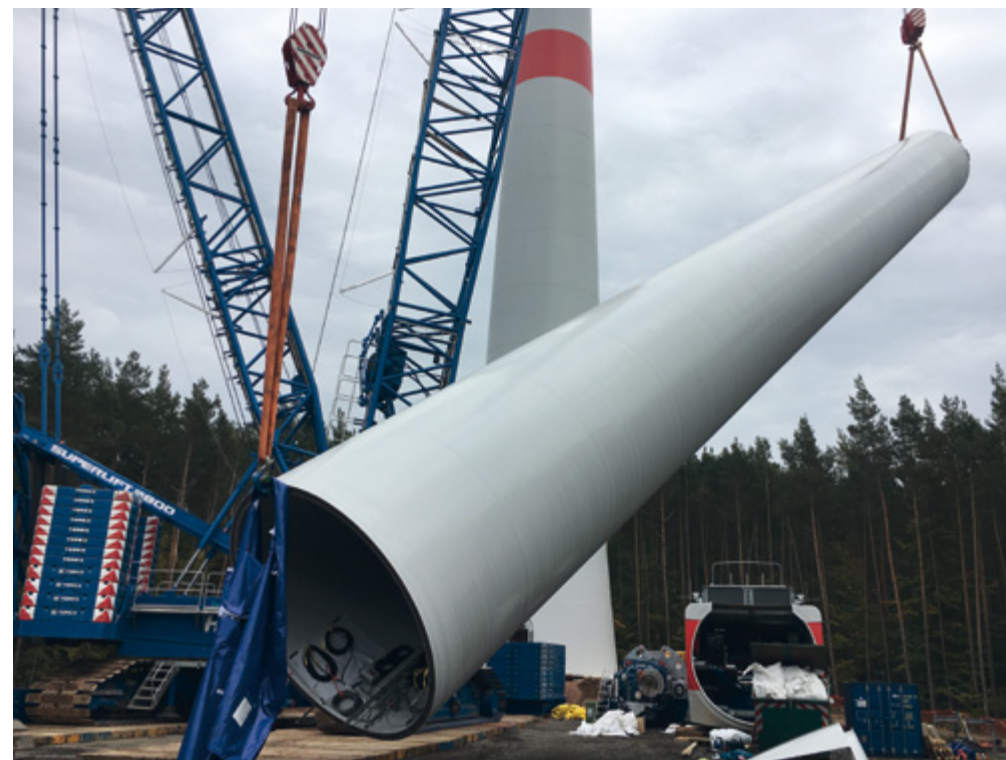
Montage eines Stahlturms
