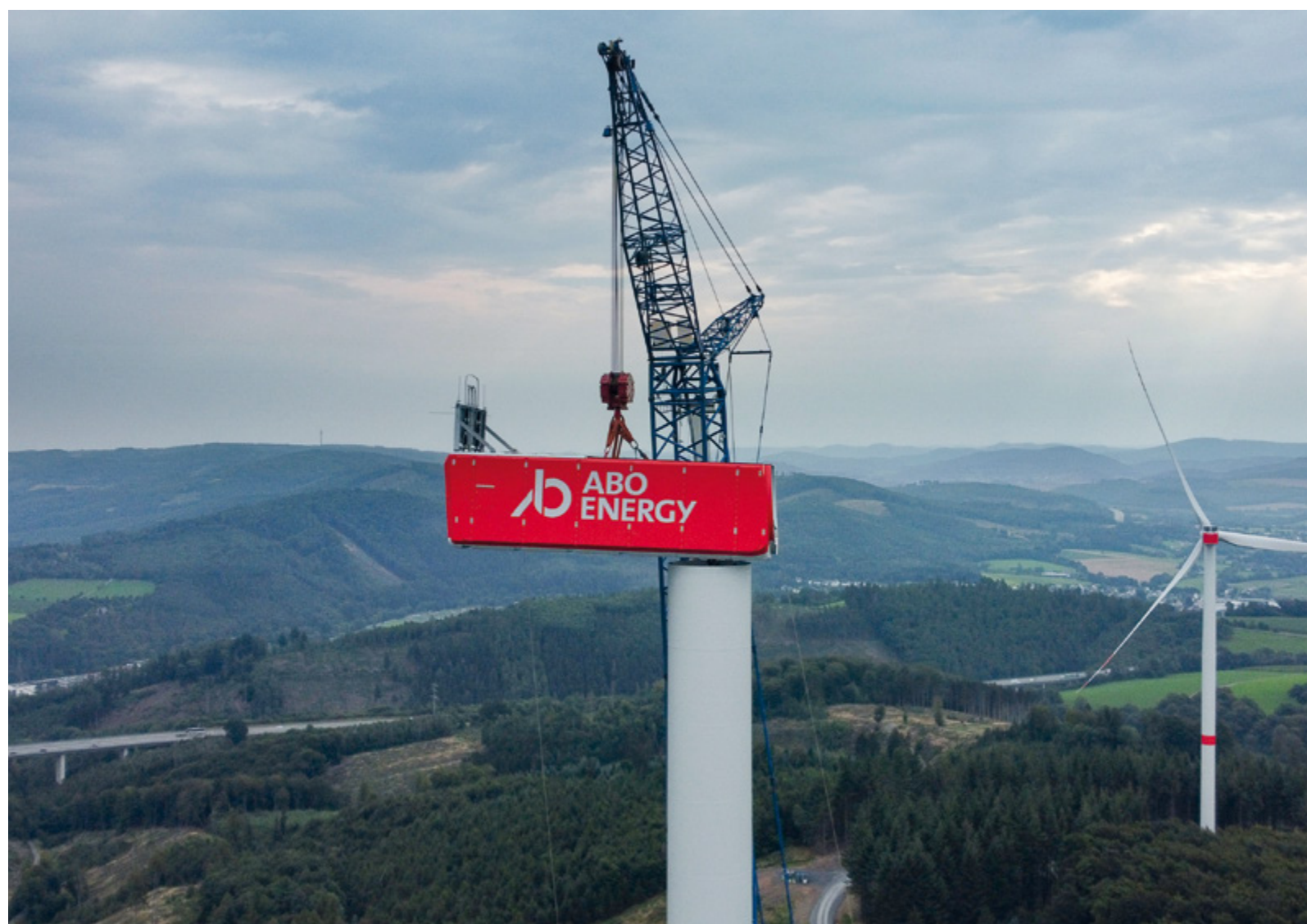
Montage des Maschinenhauses
