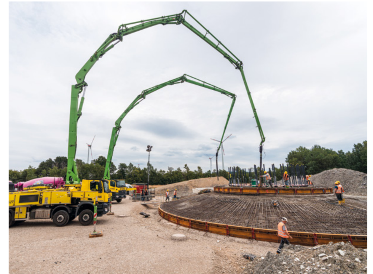
Betonage des Fundaments
