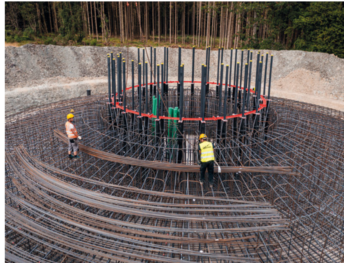
Der Fundamentkorb wird geflochten.
