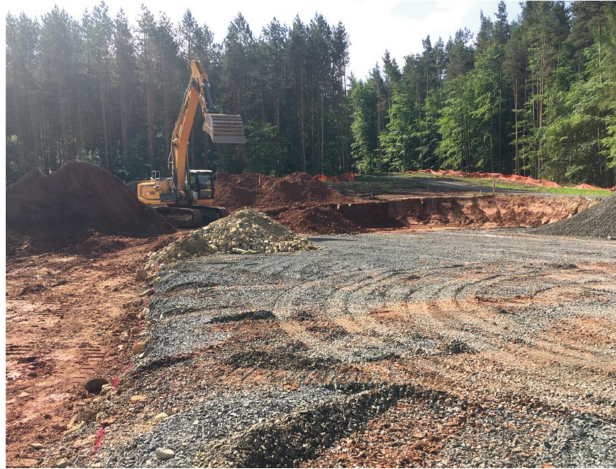
Der Standort wird für den Fundamentbau vorbereitet.
