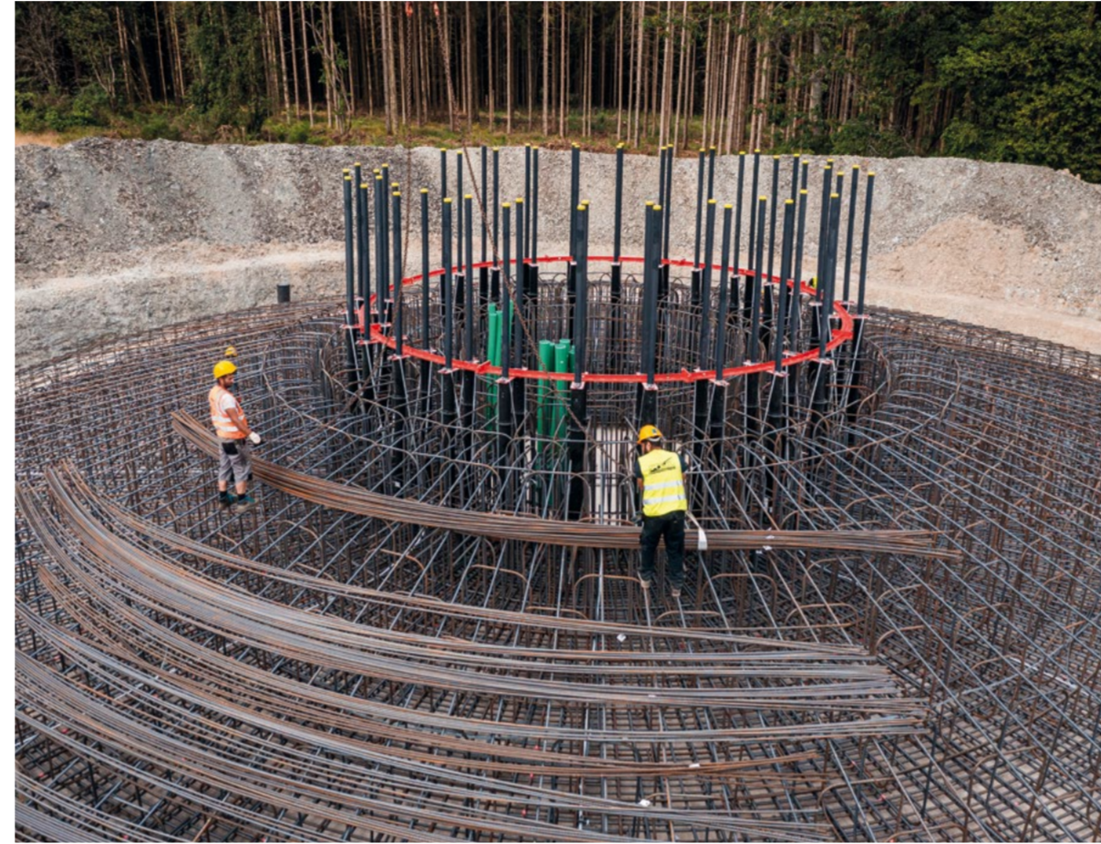
Der Fundamentkorb wird geflochten.
