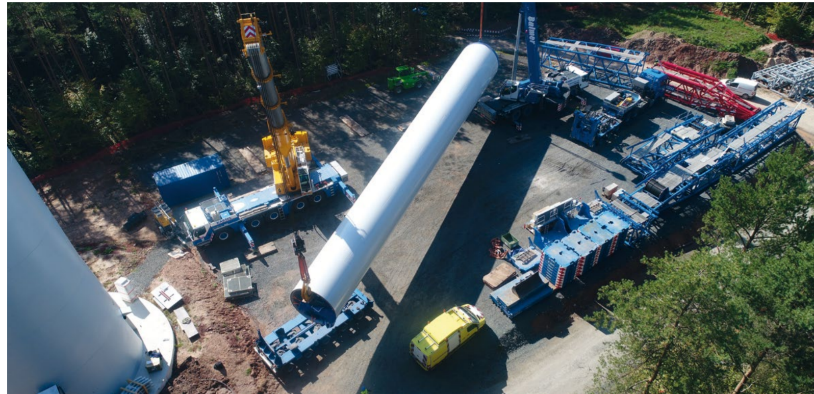
Der Stahlturm wird angeliefert
