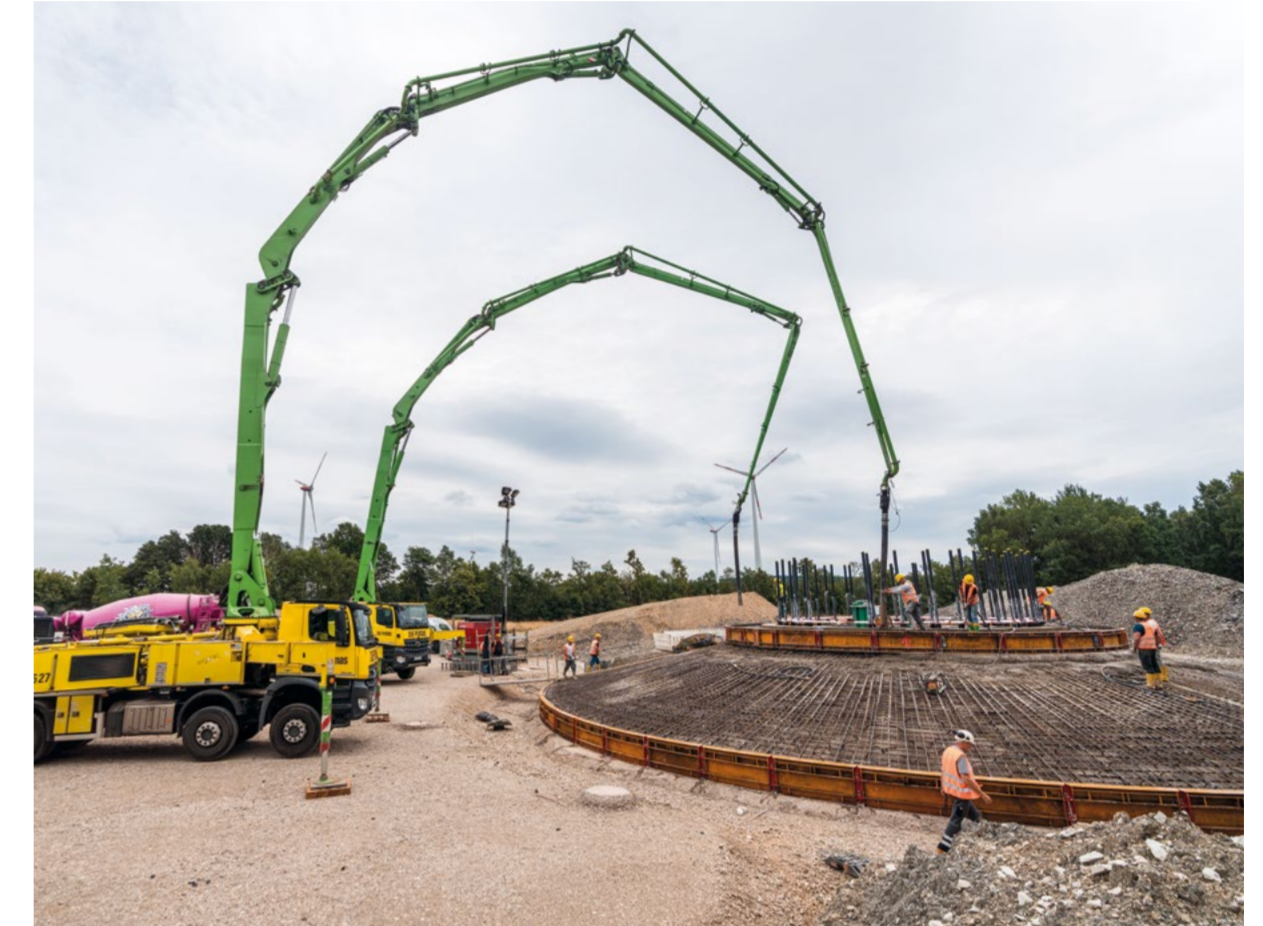
Betonage des Fundaments
