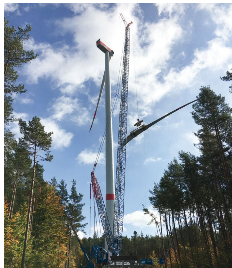
Einzel werden die Rotorblätter an die Nabe montiert
