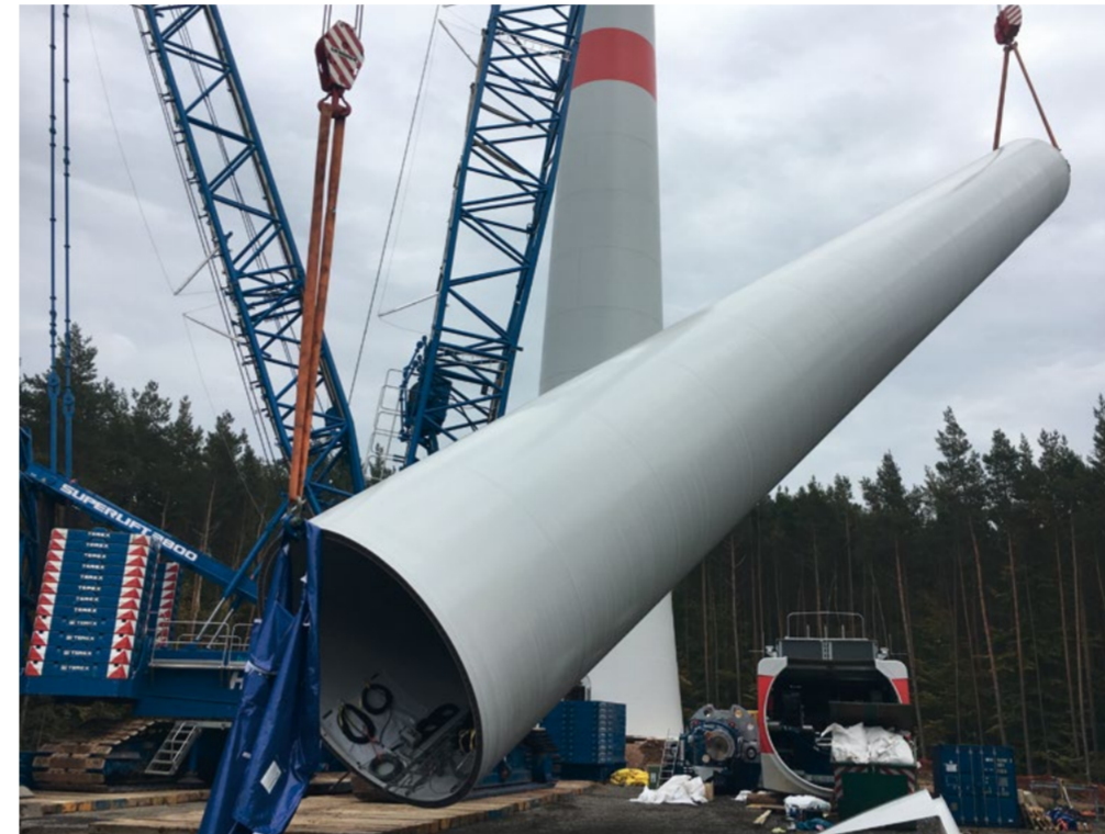
Montage eines Stahlturms
