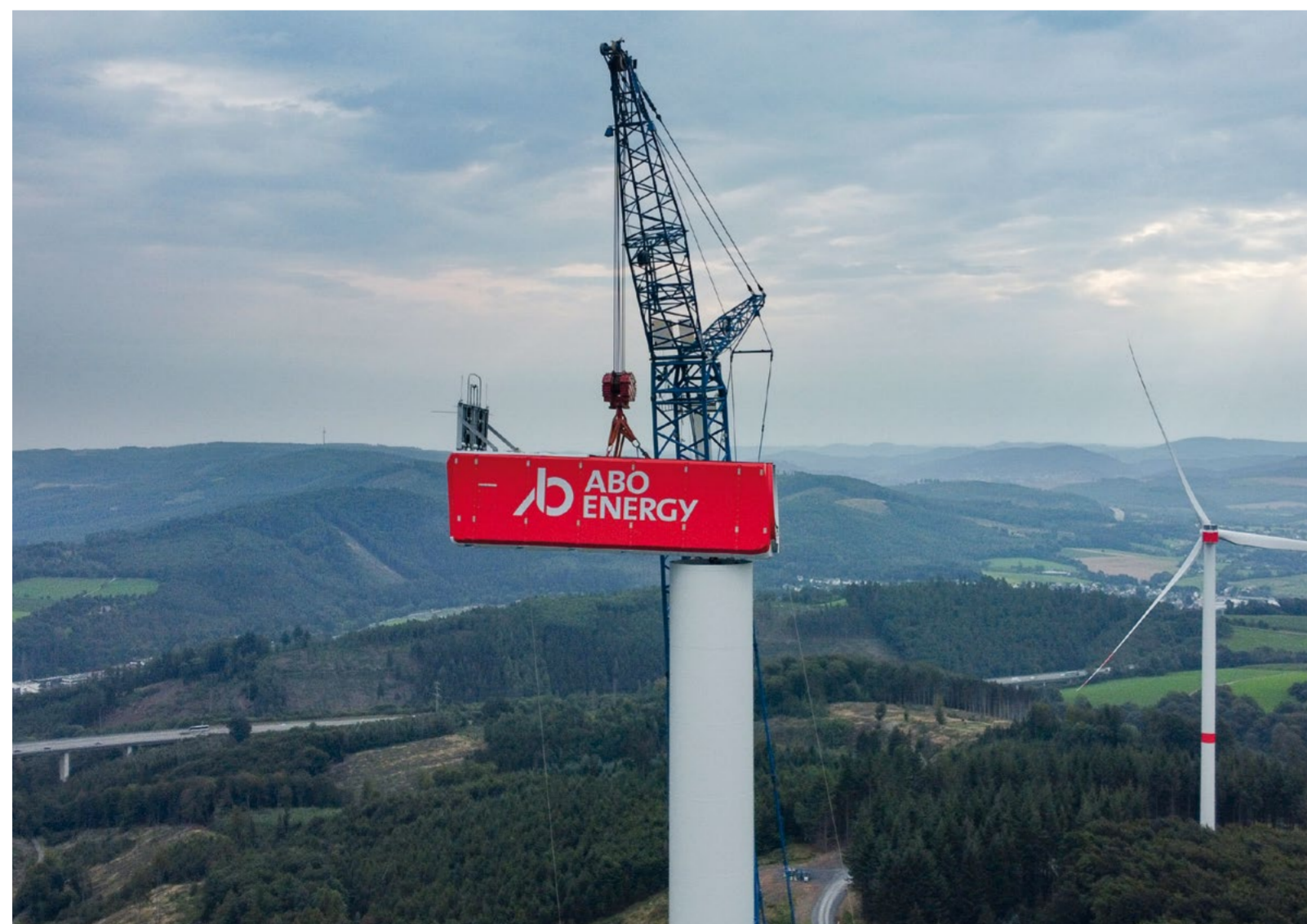
Montage des Maschinenhauses
