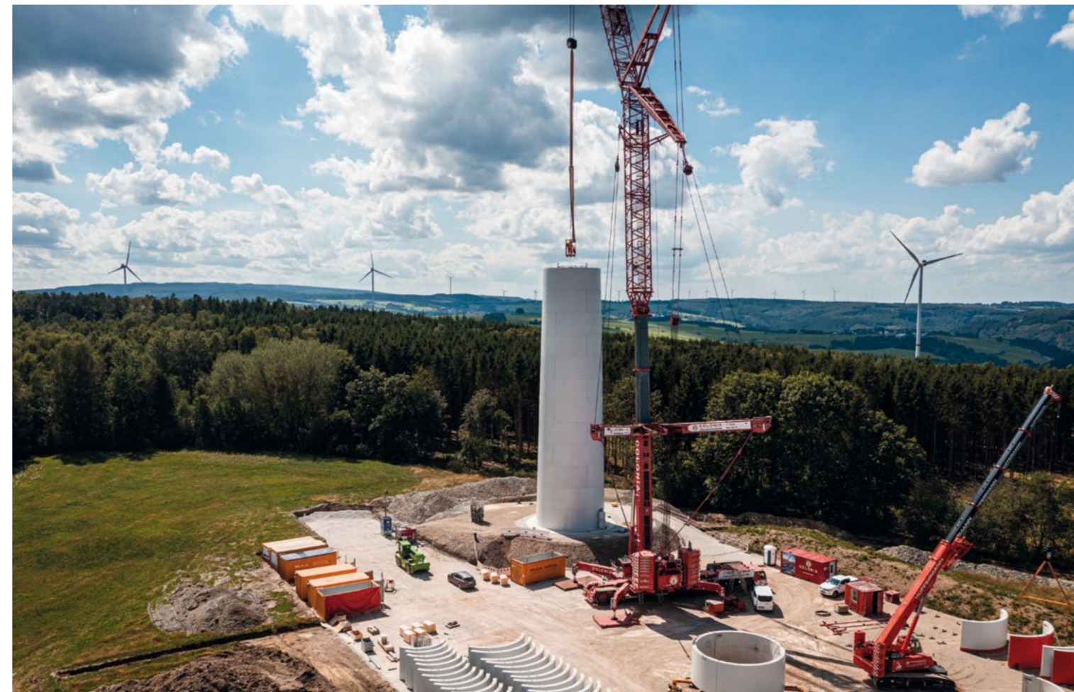
Die Turmelemente werden mithilfe eines Krans gestapelt und montiert.
