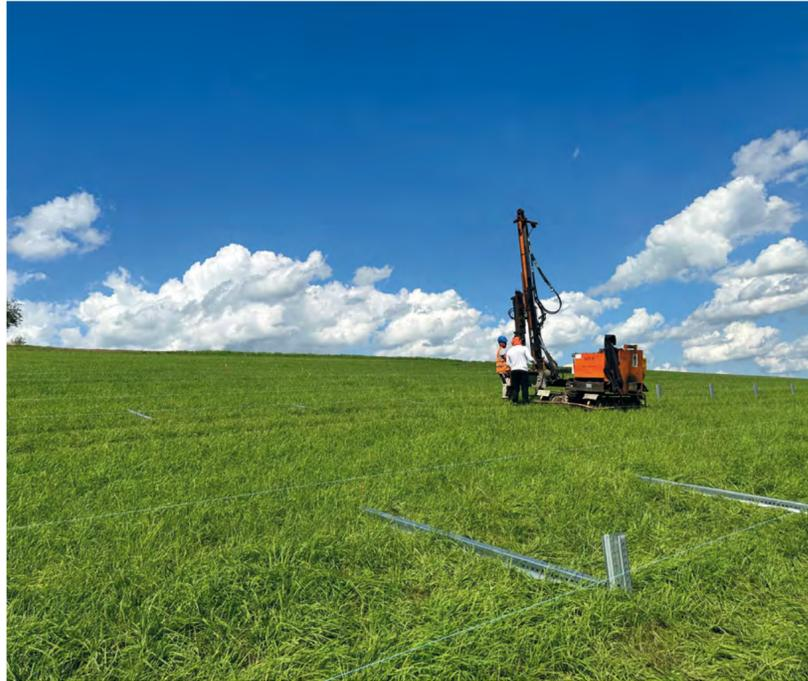
Rammvorbereitung Montage Unterkonstruktion Zerf
