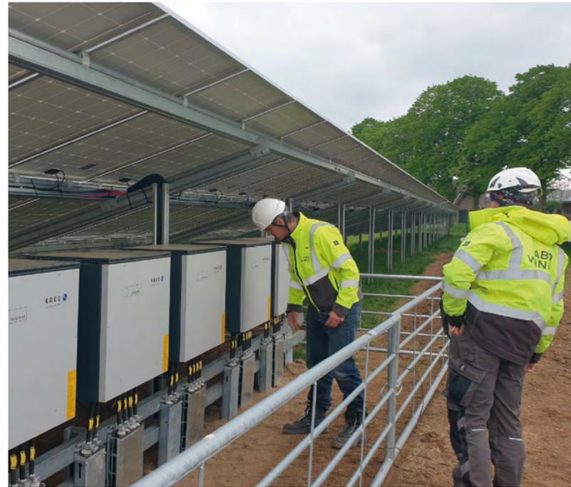
Inbetriebnahme Wechselrichter (PV-Anlage Kevelaer; 2020)
