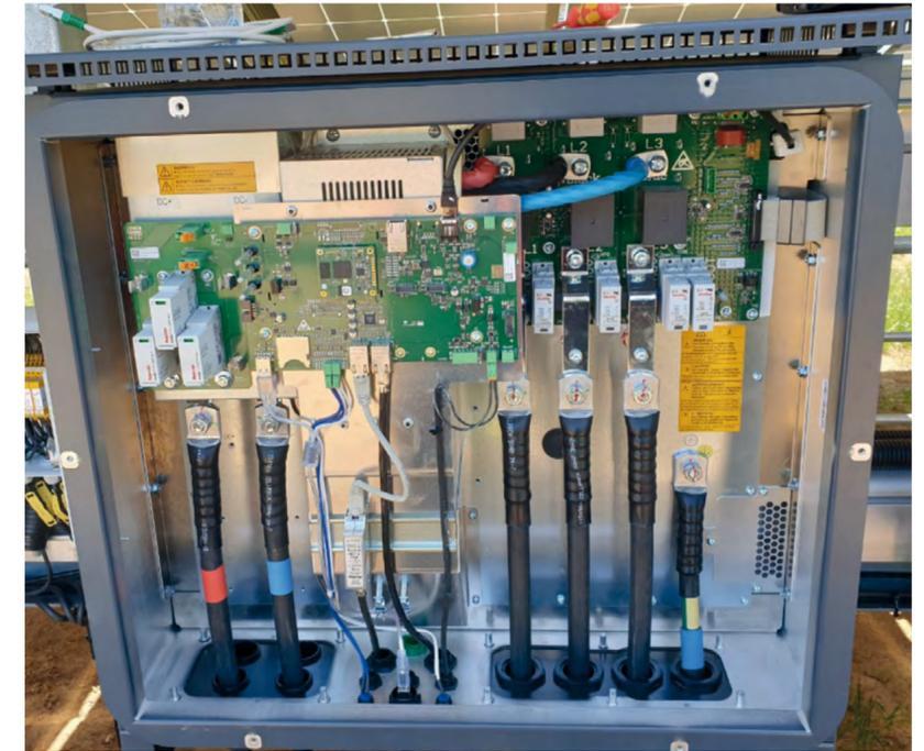
Inbetriebnahme Wechselrichter (PV-Anlage Kevelaer; 2020)
