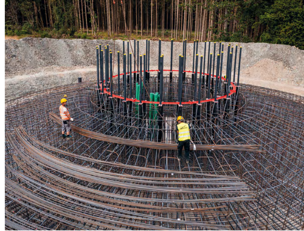
Der Fundamentkorb wird geflochten.
