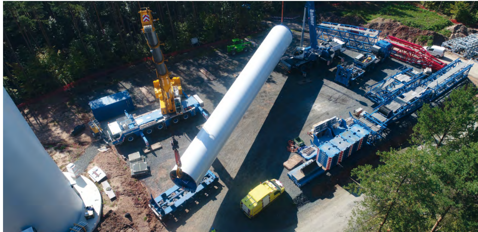
Der Stahlurm wird angeliefert
