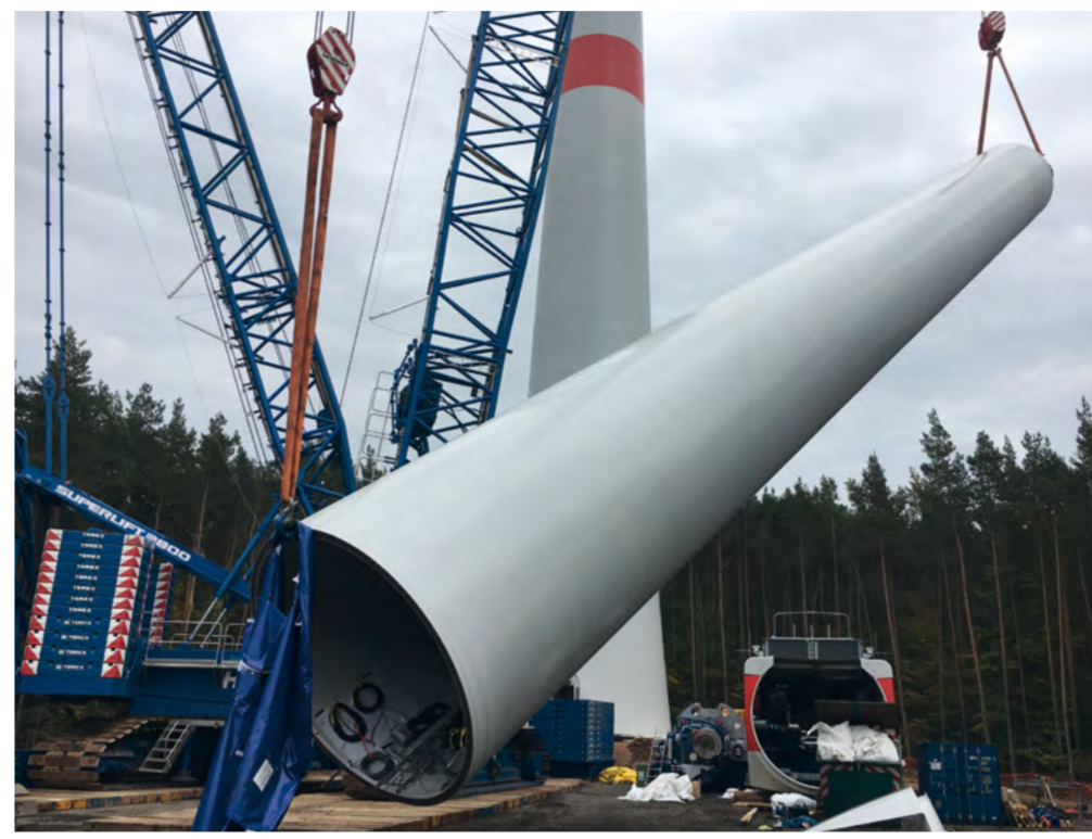
Montage eines Stahlturms
