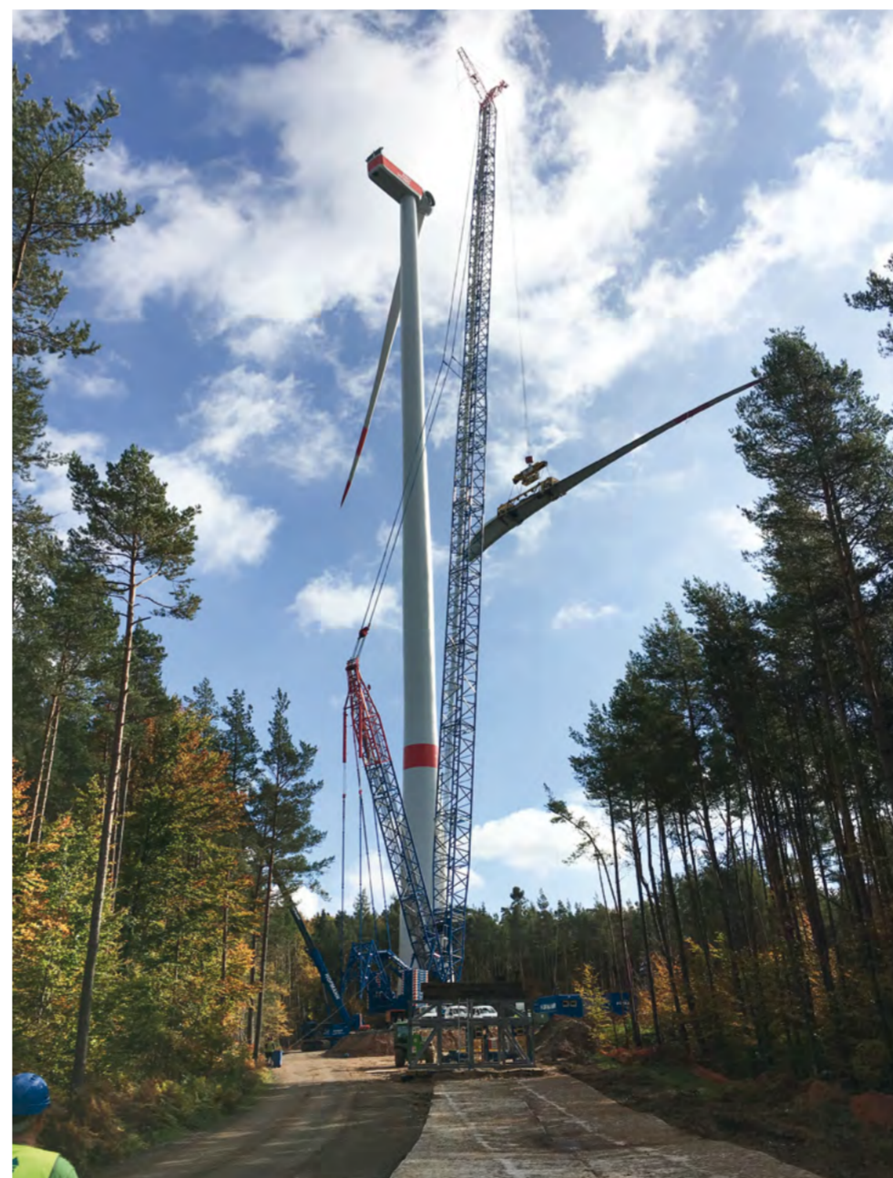
Einzel werden die Rotorblätter an die Nabe montiert
