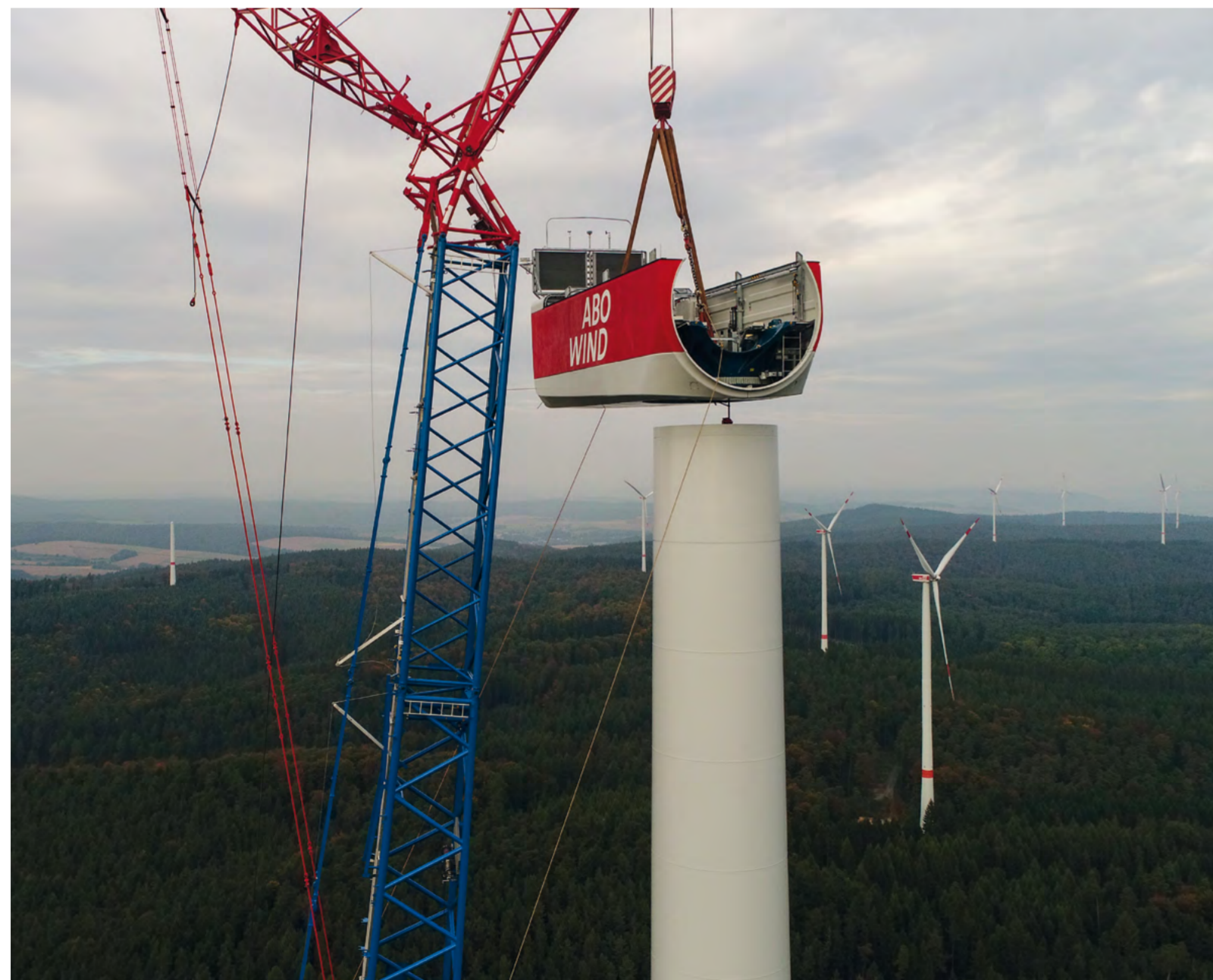
Montage des Maschinenhauses
