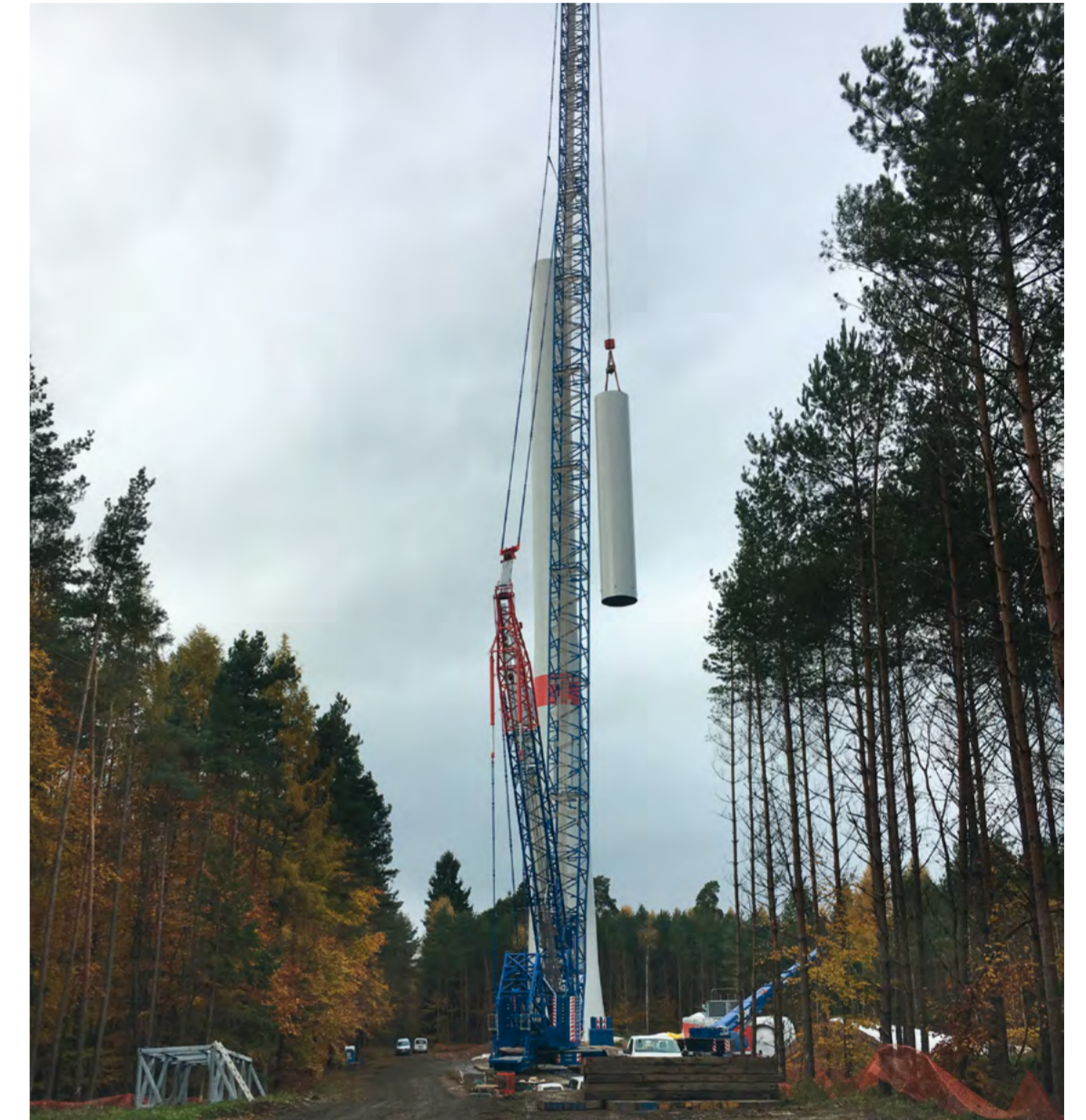
Mit zwei Stahlurmsegmenten erreicht die Anlage ihre endgültige Höhe.
