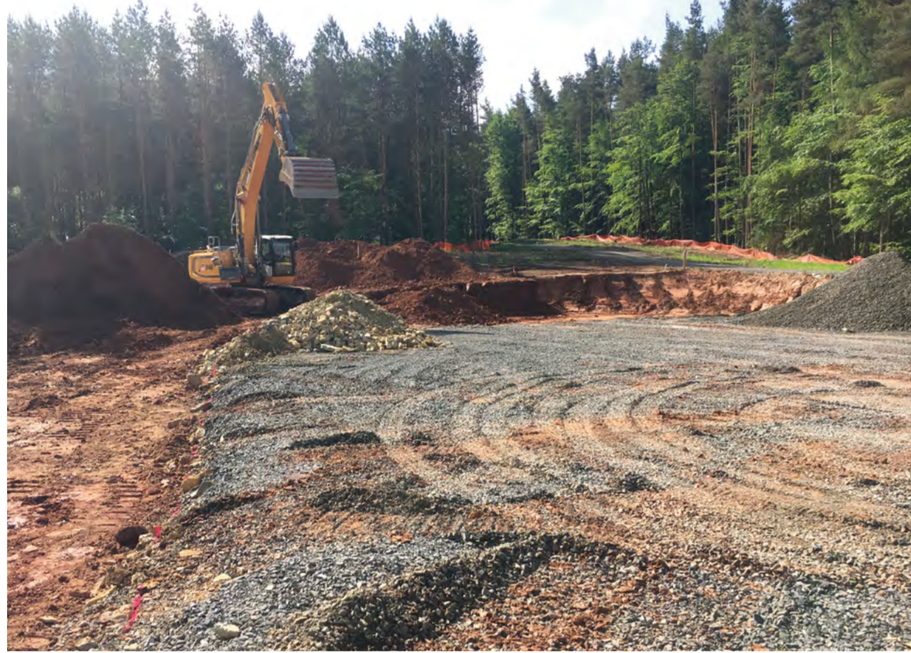
Der Standort wird für den Fundamentbau vorbereitet.
