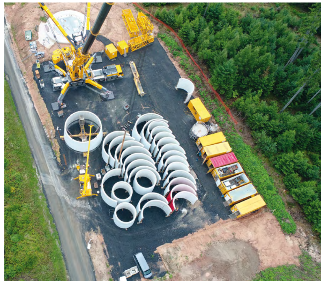
Die Betonteile des Beton-Stahl-Hybridturms werden auf dem Kranstellplatz gelagert.
