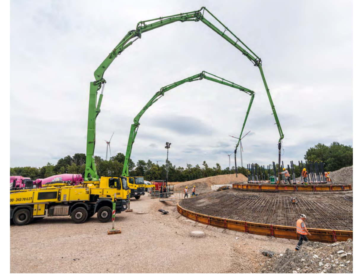
Betonage des Fundaments
